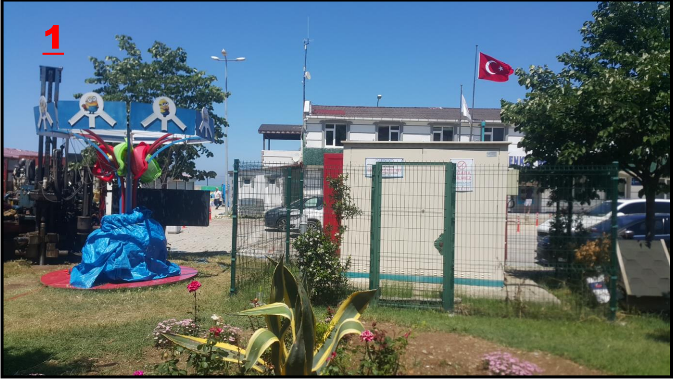
Şekil 9: Proje Sahasının Mevcut Durumu
