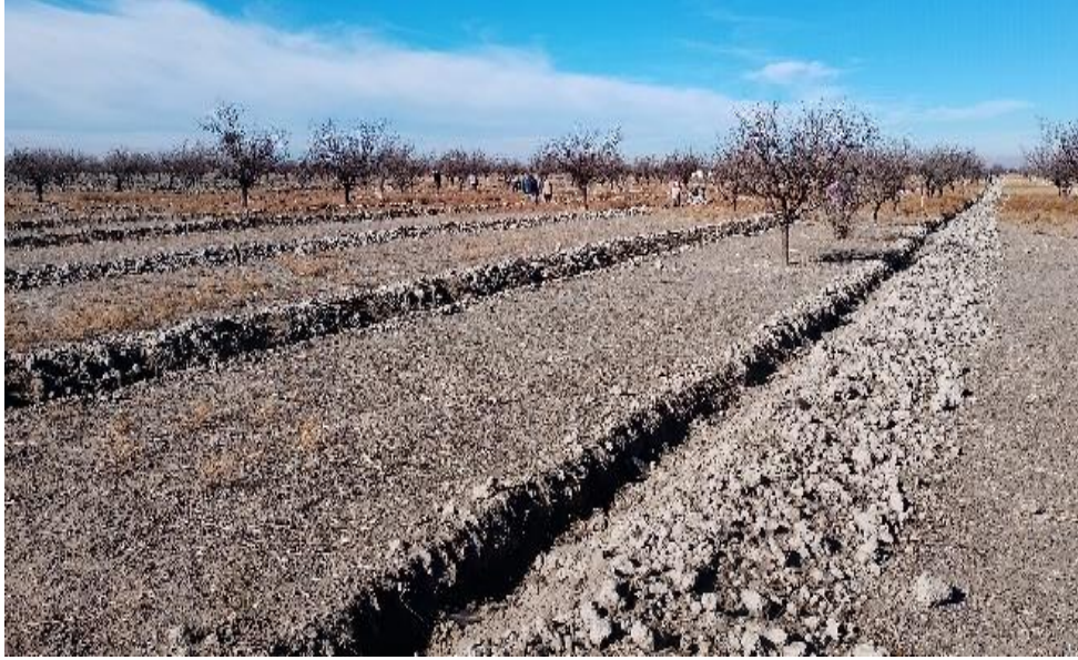
Konya / Adakale - Su Erozyonu ile Mücadele Kapsamında Oluşturulan Yutak Alan Bakım Çalışmaları
