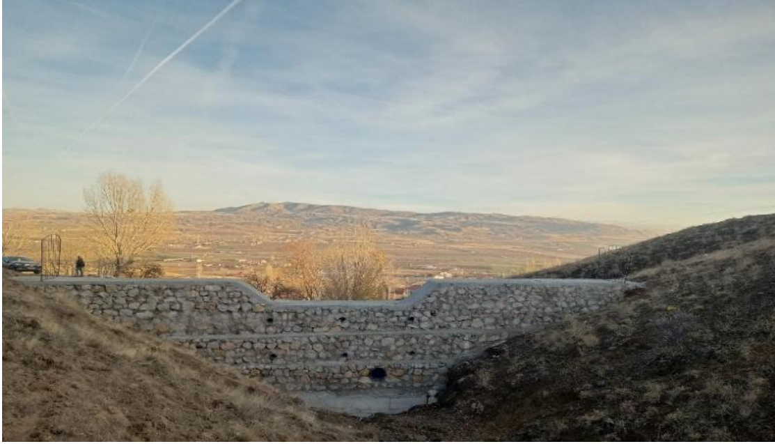
Sivas İli Gemerek İlçesi Yeniçubuk Mahallesi Yukarı Havza Sel Kontrol Uygulaması Faz-1
