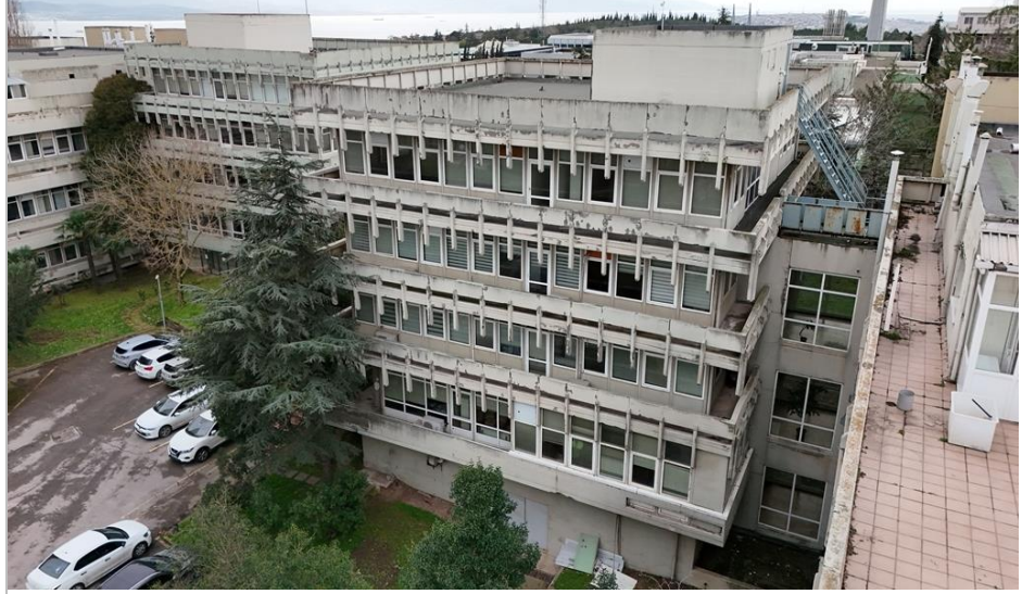
Şekil 5: MAM Gıda Laboratuvarı İdari Binası
