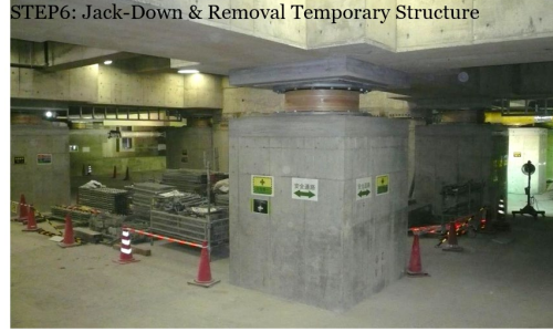
Fotoğraf 8: Deprem Yalıtım Biriminin Mevcut Bina Kolonu Üzerine Yerleşimi- Son Adım (Dr. Murakami'nin Sunumundan)
