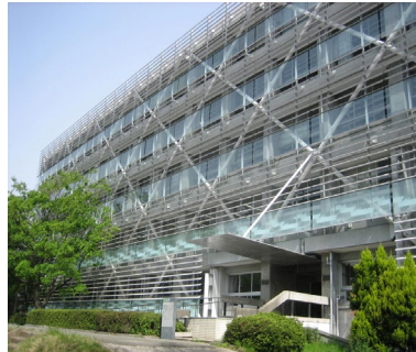
Fotoğraf 5: BRB ile Dıştan Güçlendirilen ve Güneş Kırıcılar Eklenen Japonya'daki Üniversite Binası (Prof. Wada'nın Sunumundan Toru Takeuchi'den Alıntı ile)
