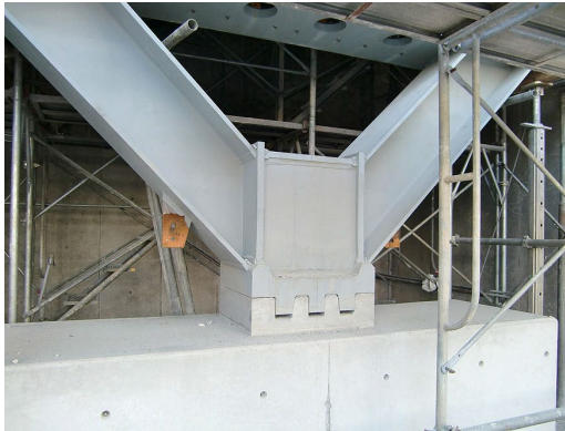
Fotoğraf 4: Üniversite Binasını Güçlendirmek İçin Kullanılan Dişli Tip Esnek Akma Sönümleyici
