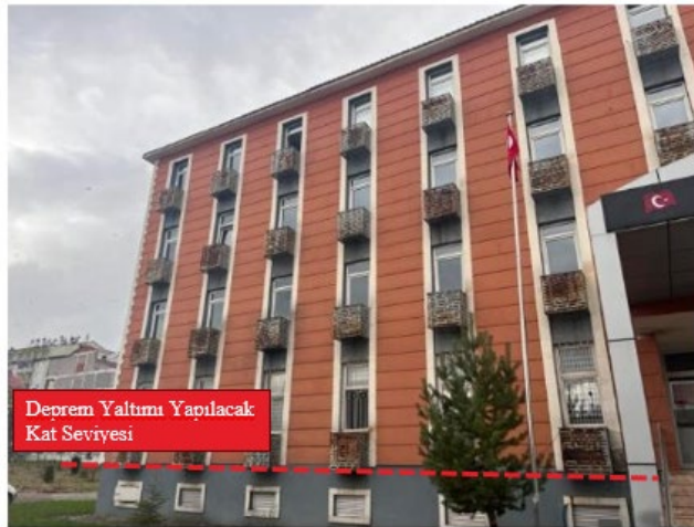
Şekil 37: Tunceli Hozat Hükümet Konağı Deprem Yalıtım Seviyesi
