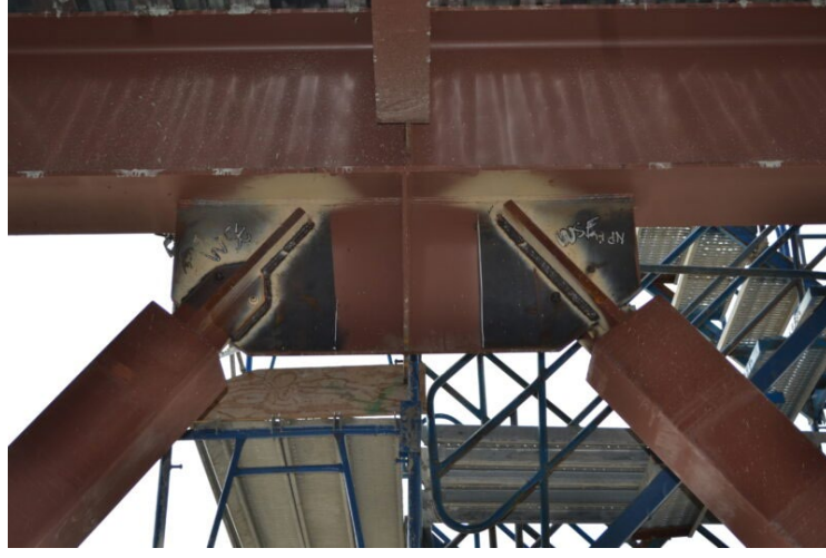
Fotoğraf 1: BÖÇ Elemanların Kaynaklı Uç Bağlantısı
