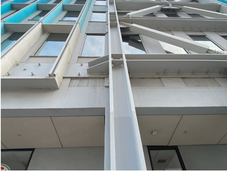
Fotoğraf 4: Dışarıdan BÖÇ Elemanları ile Güçlendirme ve Mevcut Binaya Ankraj Bağlantıları
