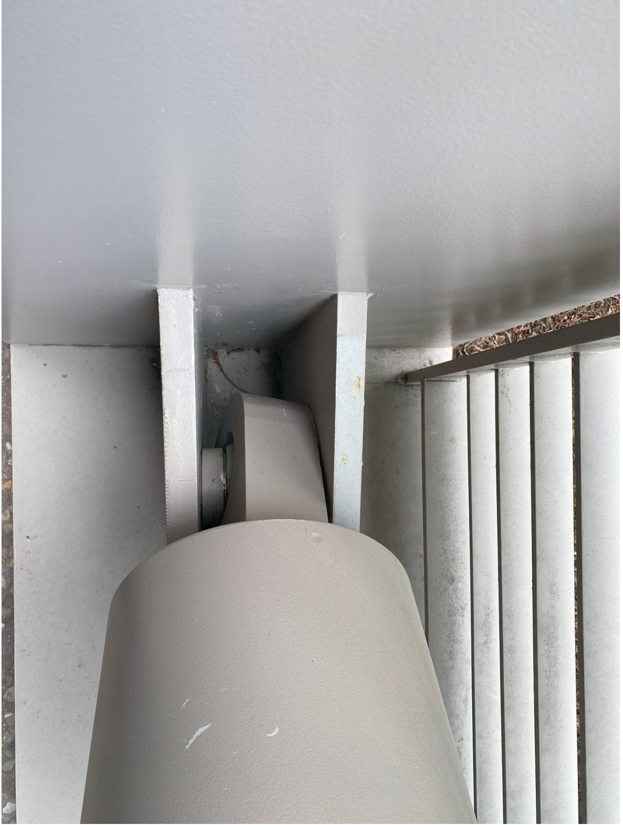
Fotoğraf 10: Sönümleyicili Çapraz Eleman Küresel Bağlantı Deliği
