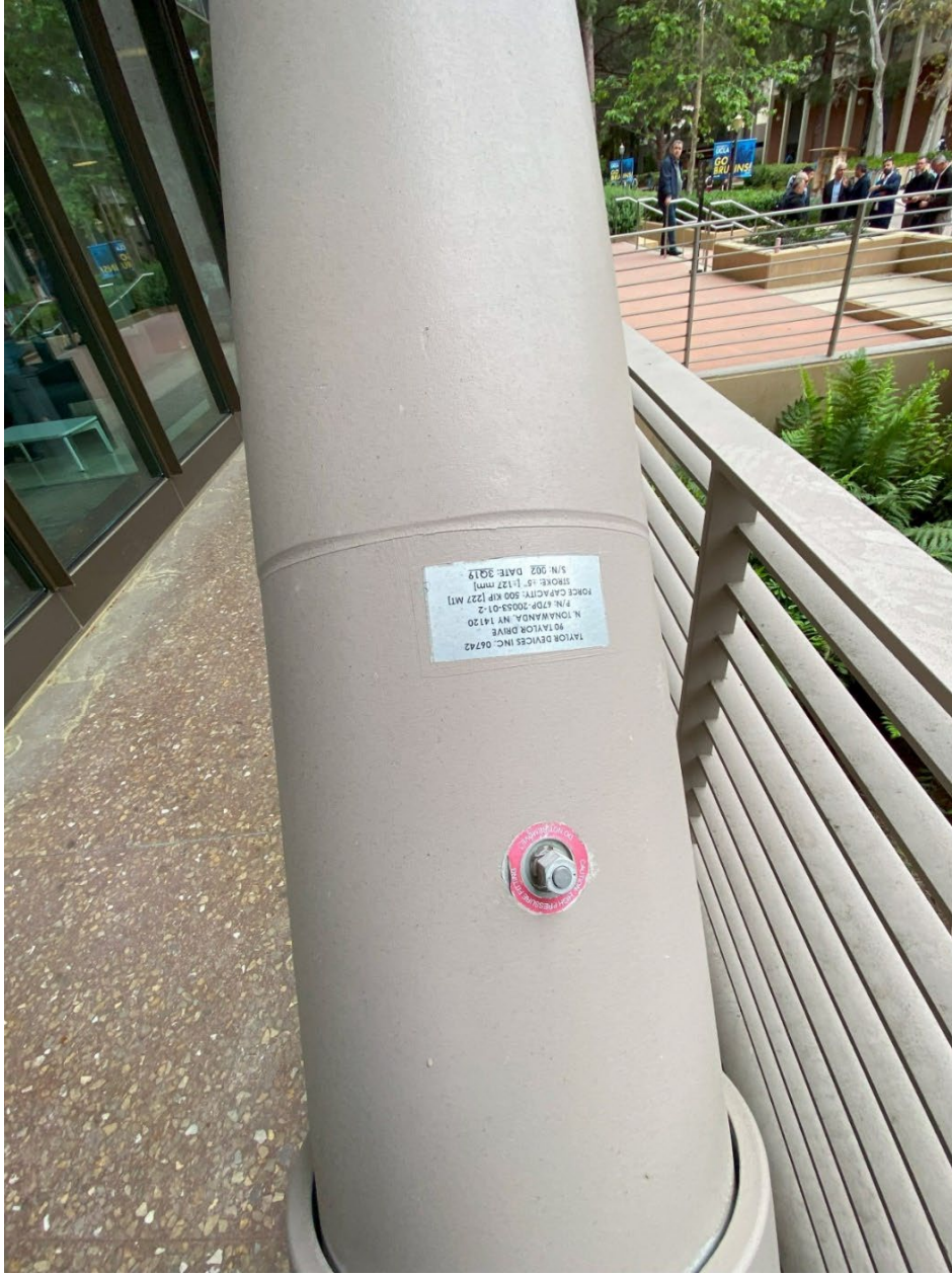
Fotoğraf 11: Yüksek Basıncı Viskoz Sıvı Dolum Noktası
