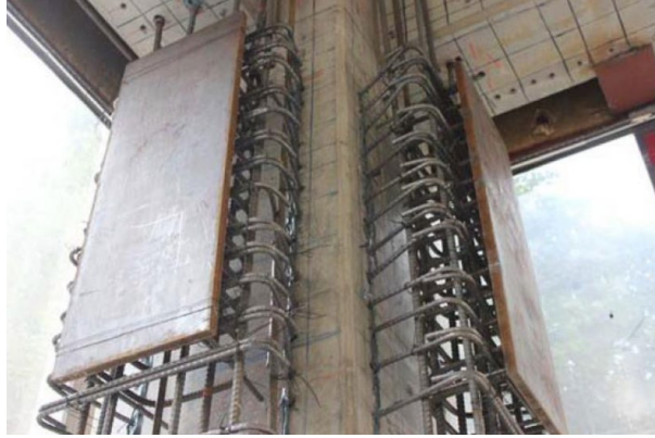
Fotoğraf 5: Beton İçerisinde Bırakılan Düğüm Noktası Bağlantı Elemanları (Taylor Devices Inc.)
