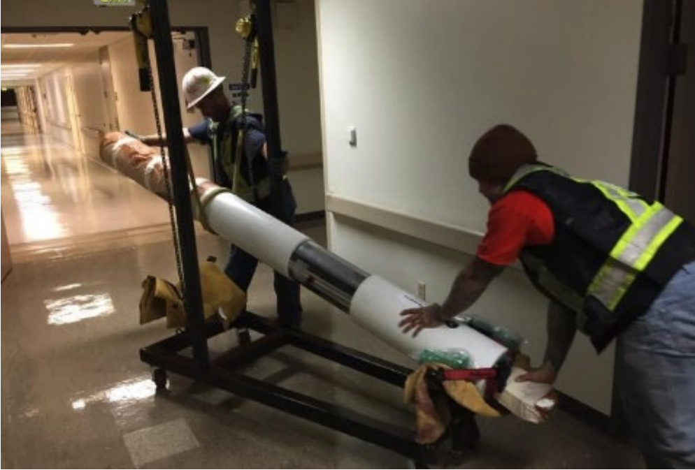
Fotoğraf 8: Sönümleyicili Çapraz Elemanların Bina İçerisindeki Nakliyesi (Taylor Devices Inc.)
