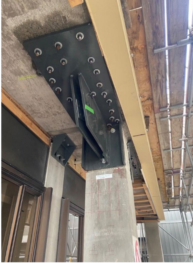
Fotoğraf 3: Mevcut Betonarme Elemanlara Bağlantı için Kullanılan Kimyasal Ankrajlar
