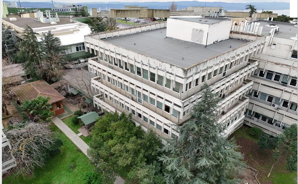
Şekil 4: MAM Gıda Laboratuvarı Binası
