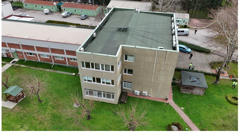
Şekil 6: MAM İdari Ek Binası
