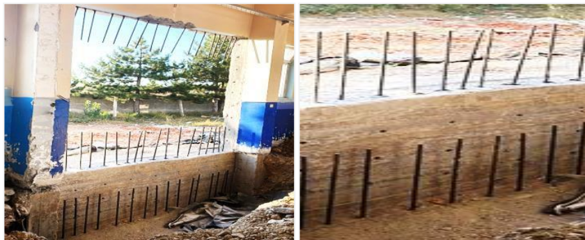
Şekil 8 Ankraj Çubuklarının Çakılması Örnek Görsel
