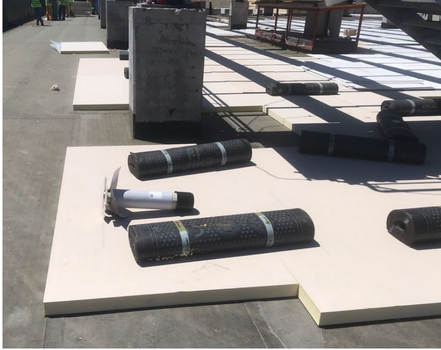
Fotoğraf 17: Mevcut Bir Yapının Teras Çatısına Eklenen Yalıtım Katmanı - [Arup]
