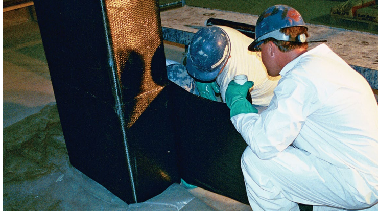
Fotoğraf 7: LF ile Sargılama Uygulama Örneği- (Jdashevsky, 2024)
