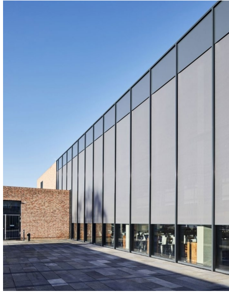
Fotoğraf 27: Almanya’da Okul Cephesinde Dış Stor Kullanımı Örneği- [Serge Ferrari]
