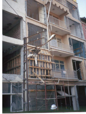
Fotoğraf 2: Fotoğraf-1'deki Binanın Güçlendirme Sırasında ve Güçlendirme Sonrasındaki Ön Cephe Görüntüsü
