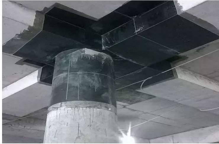
Fotoğraf 8: LF ile Sargılama Uygulama Örneği- (FRP Applications, 2024)
