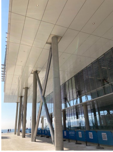
Fotoğraf 12: Yeni Yapıda Çelik Çapraz Kullanılarak Tasarım ve Uygulama Örneği – [Arup – İstanbul Modern Müzesi]
