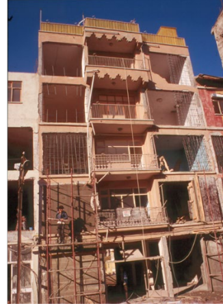
Fotoğraf 1: Perde Duvar İlavesi Yöntemi ile Güçlendirme (Güçlendirme Öncesi Ve Güçlendirme Uygulaması Sırasında Bina Ön Cephe Görüntüsü)
