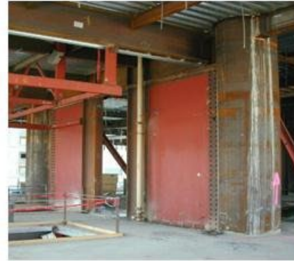
Fotoğraf 10: Betonarme Perde Eklenmesi Örnek Uygulama- (Utkucu, Budakoğlu, & Gülen, 2011)
