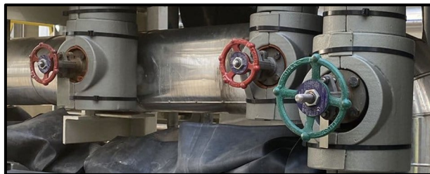
Fotoğraf 32: Dış Ortam Boru ve Vana Yalıtım Uygulama Görüntüsü
