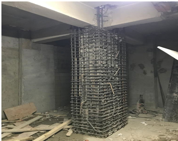
Fotoğraf 4: Betonarme Eleman ile Kolon Sargılama Uygulama Örneği – © HİLTİ
