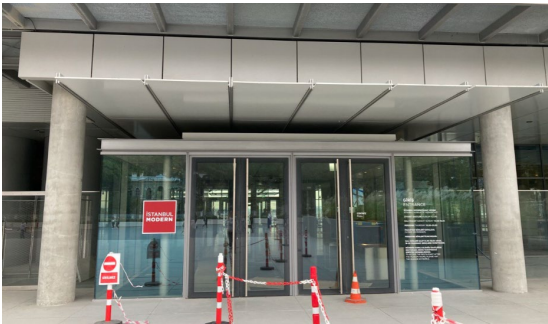
Fotoğraf 18: Rüzgarlık Dış Doğramasında Kayar Kapı İç Doğramasına Döner Kapı Kullanılarak Enerji Verimliliği Sağlanan Müze Girişi
