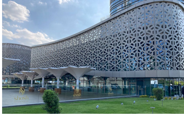
Fotoğraf 22: Özbekistan-Taşkent'te Genleştirilmiş Perfore Alüminyum Gölgelendirme Elemanı İle Enerji Verimliliği Sağlanmış Otel Cephesi- [Arup]
