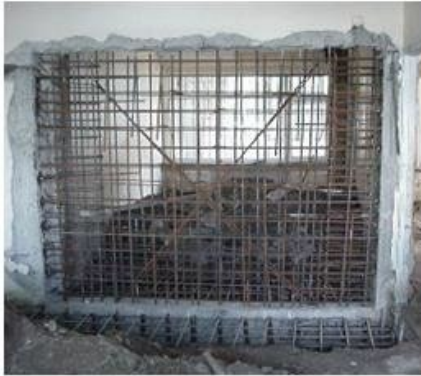
Fotoğraf 10: Betonarme Perde Eklenmesi Örnek Uygulama- (Utkucu, Budakoğlu, & Gülen, 2011)
