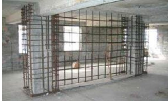
Fotoğraf 9: Betonarme Perde Eklenmesi Örnek Uygulama- (Rasol, Eren, & Şensoy, 2014)
