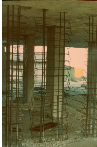
Fotoğraf 3: İlave Kolon ile Güçlendirme
