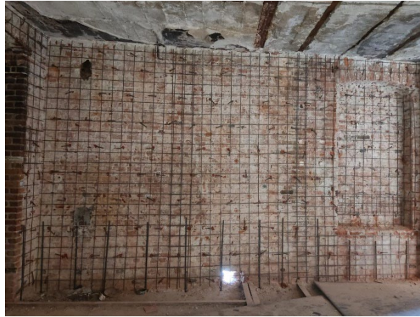
Fotoğraf 15: Yığma Duvarların Hasır Çelik ile Güçlendirilmesi © HİLTİ
