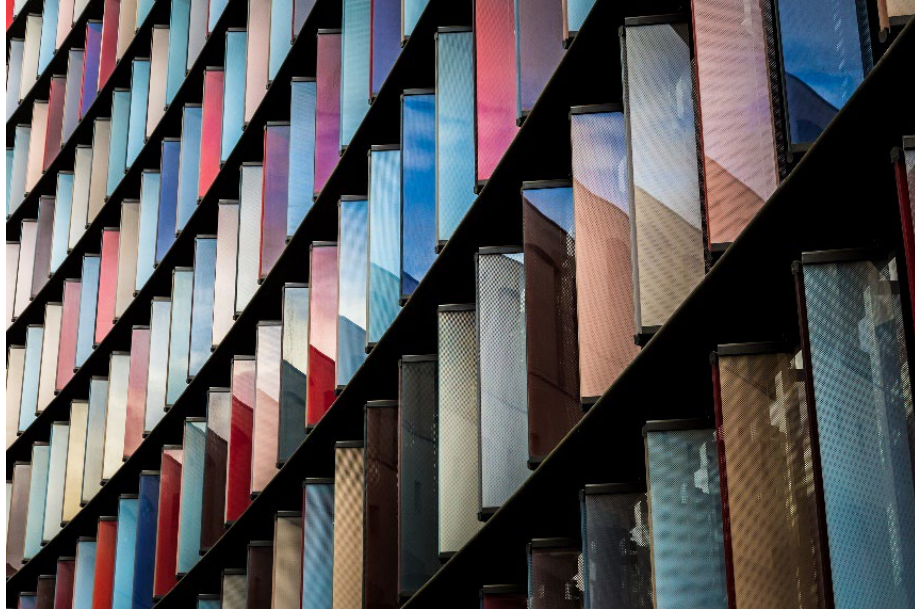
Fotoğraf 20: Cephesinde Hareketli Dikey Güneş Kırıcı Elemanlar Kullanılmış Yapı Örneği- [Stock Images]
