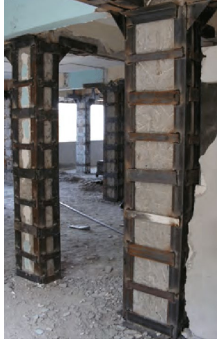
Fotoğraf 6: Çelik Elemanlarla Sargılama Uygulama Örneği – (Kaplan & Yılmaz, 2012)
