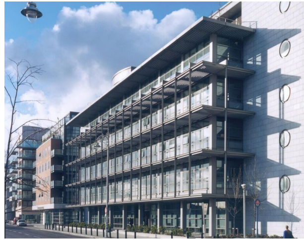
Fotoğraf 23: İrlanda – Dublin’de A&L Goodbody Corporate Offices Yapısının Cephesinde Kullanılan Gölgeleme Elemanları- [Studioworks, Arup]
