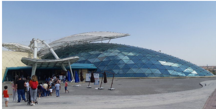
Fotoğraf 30: Düşük Emisyonlu Güneş Kontrol Camı Sistemi Kullanılmış Yapı Örneği- Konya Tropikal Kelebek Bahçesi ve Böcek Müzesi - [Arup]
