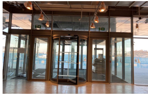
Fotoğraf 18: Rüzgarlık Dış Doğramasında Kayar Kapı İç Doğramasına Döner Kapı Kullanılarak Enerji Verimliliği Sağlanan Müze Girişi
