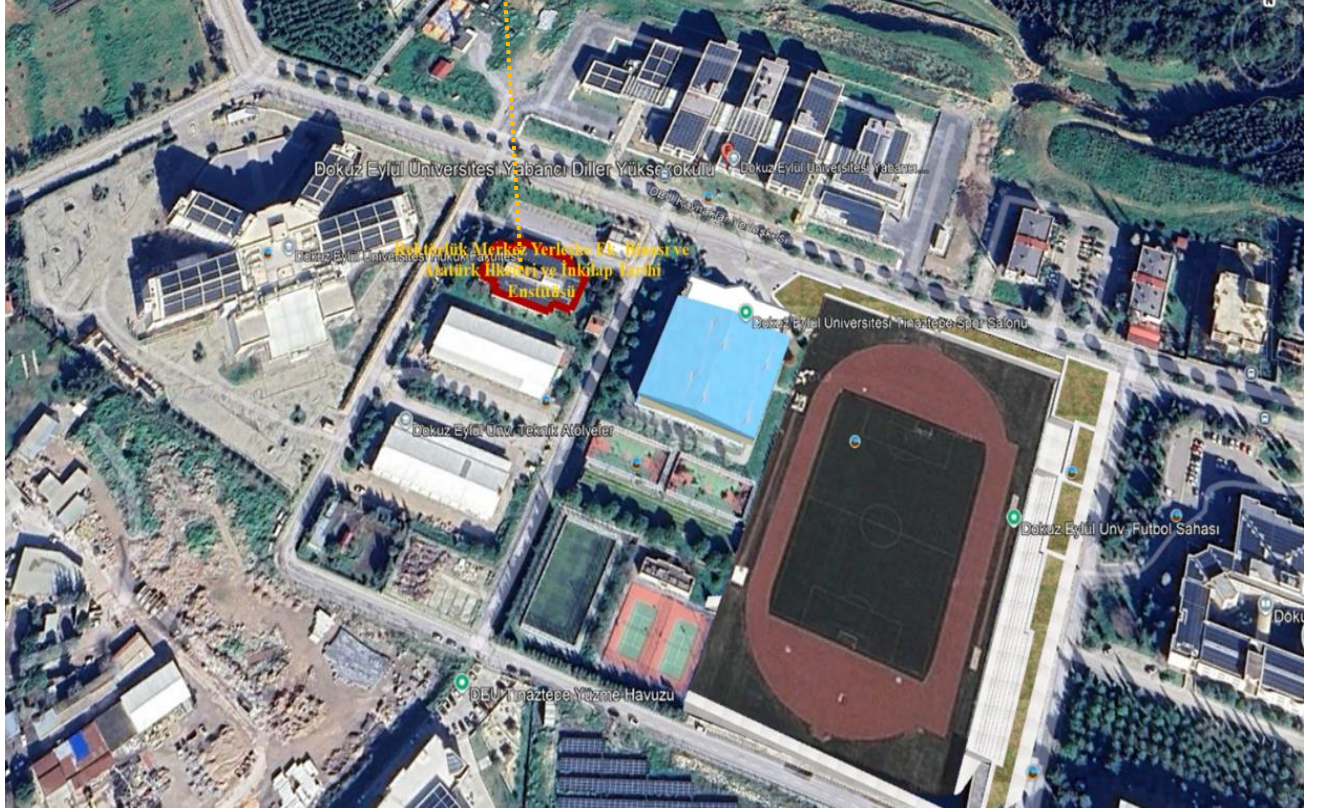
Şekil 1: Tınaztepe Kampüsü, Rektörlük Merkez Yerleşke Ek Binası ve Atatürk İlkeleri ve İnkılap Tarihi Enstitüsü Binası
