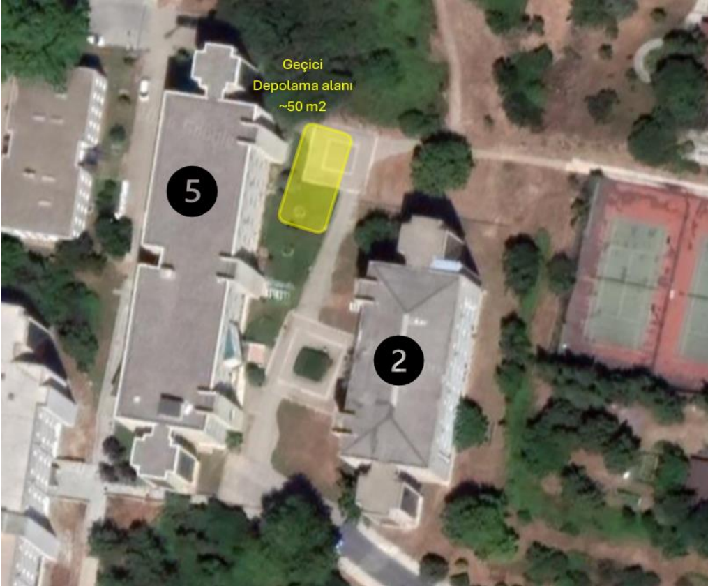
Şekil 6 İTÜ Ayazağa Yerleşkesi Ferhunde Birkan Kız Yurdu Binası Geçici Depolama Alanı
