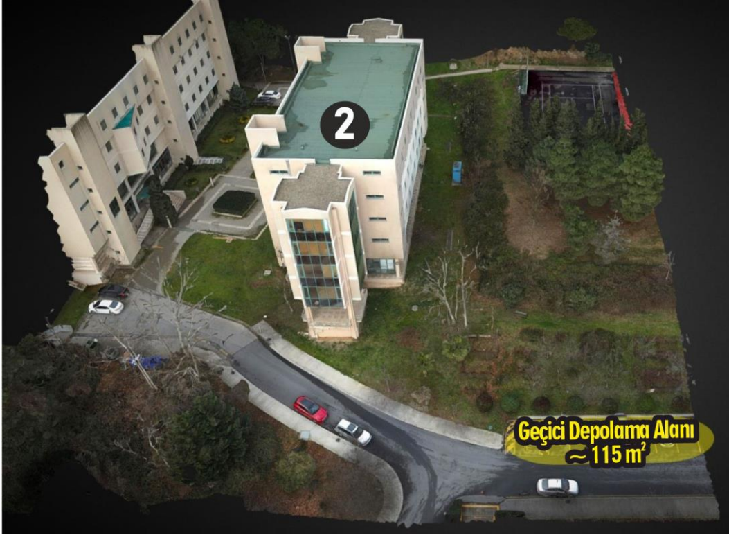
Şekil 2 İTÜ Ayazağa Yerleşkesi Ayazağa Kız Öğrenci Yurdu Binası Geçici Depolama Alanı
