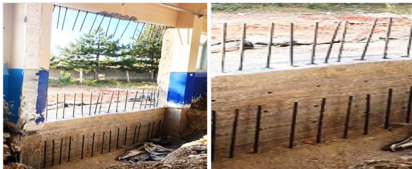
Şekil 11: ANKRAJ ÇUBUKLARININ ÇAKILMASI ÖRNEK GÖRSEL
