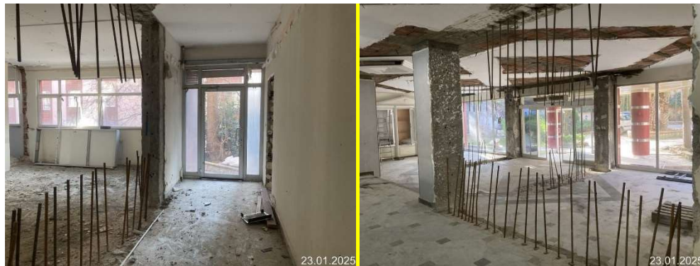
Şekil 20 Ankraj Çubuklarının Çakılması Örnek Görsel
