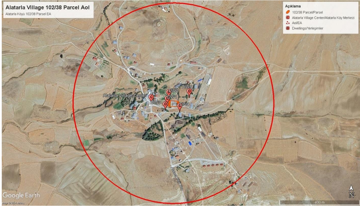
Şekil 18. Alatarla Köyü 102/38 Parsel Uydu Görüntüsü
