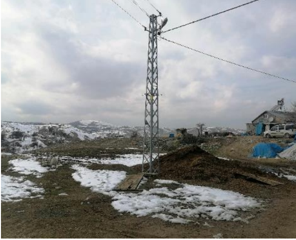
Fotoğraf 86. Parselin Yakınındaki Elektrik İletim Hattı
