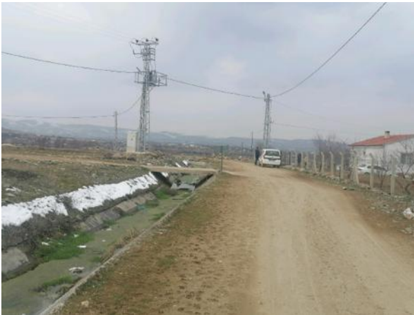
Fotoğraf 11. Köy Yolu ve Sulama Kanalı
