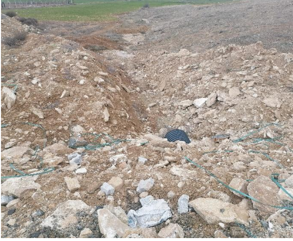
Fotoğraf 44. Alt Yapı Çalışması (Borulama)
