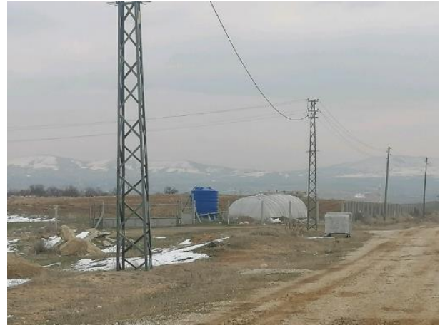
Fotoğraf 99. EA'da Elektrik İletim Hatları ve Su Depolama Tankı (Parsele dahil değildir.)
