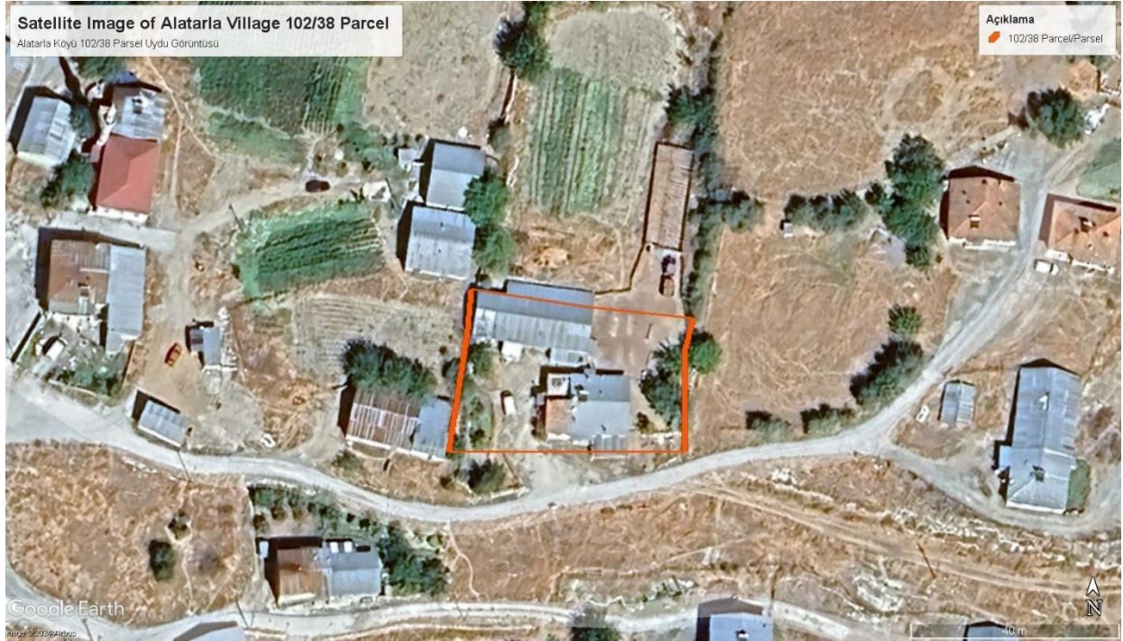
Şekil 17. Alatarla Köyü 102/38 Parsel Uydu Görüntüsü
