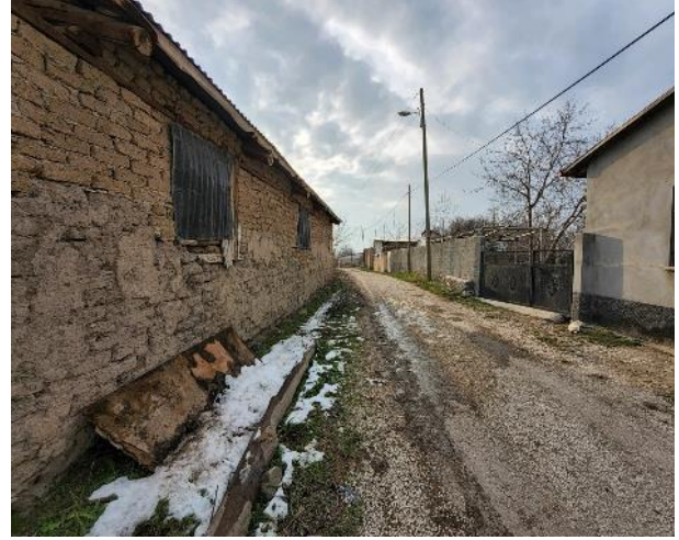
Fotoğraf 25. Parselin Yanındaki Köy Yolu
