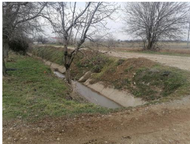
Fotoğraf 109. Parsel EA'sındaki Sulama Kanalı (Parsele dahil değildir.)
