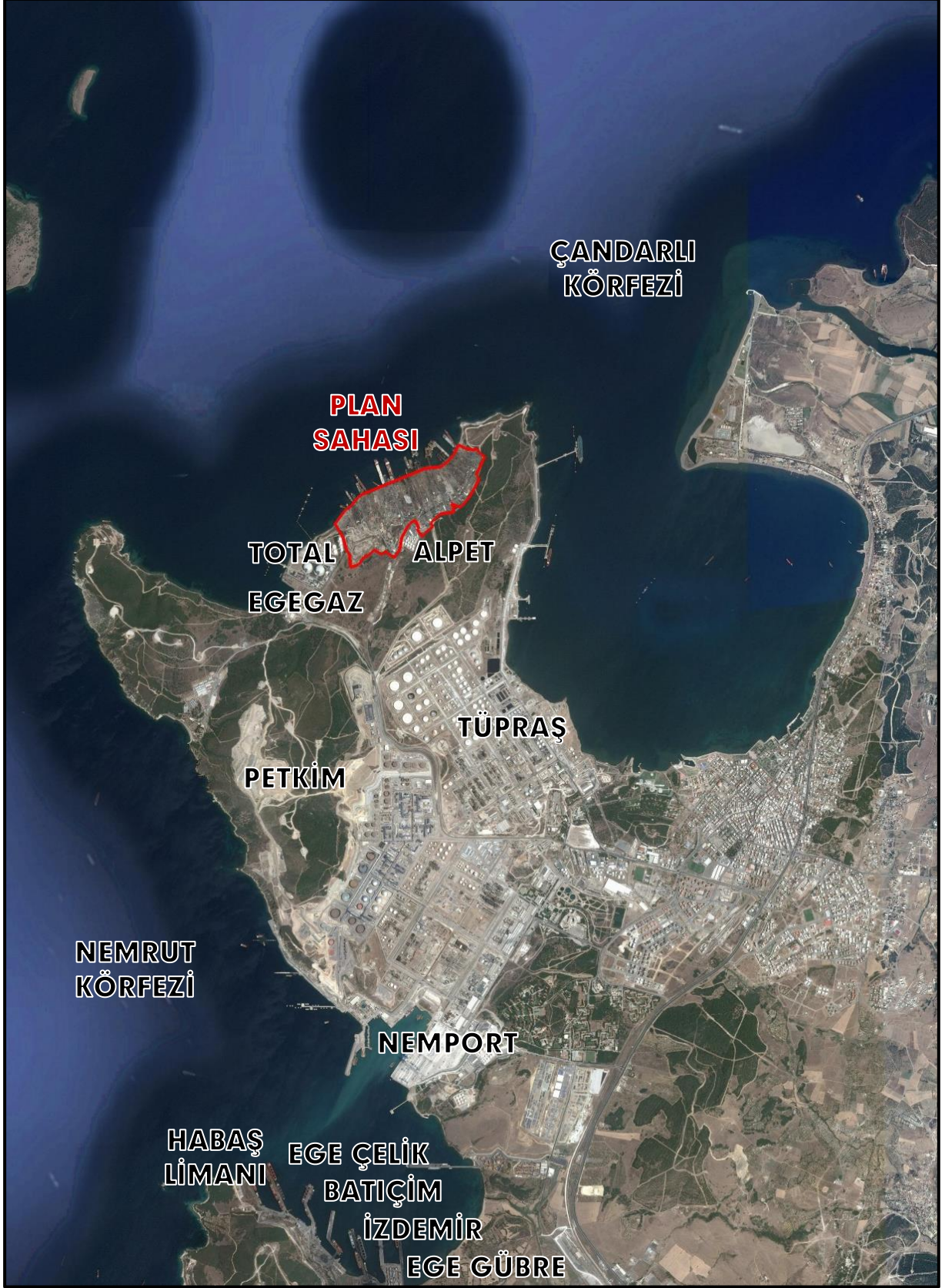
Şekil 11: Plan Sahası Yakın Çevresindeki Kıyı Tesisleri
