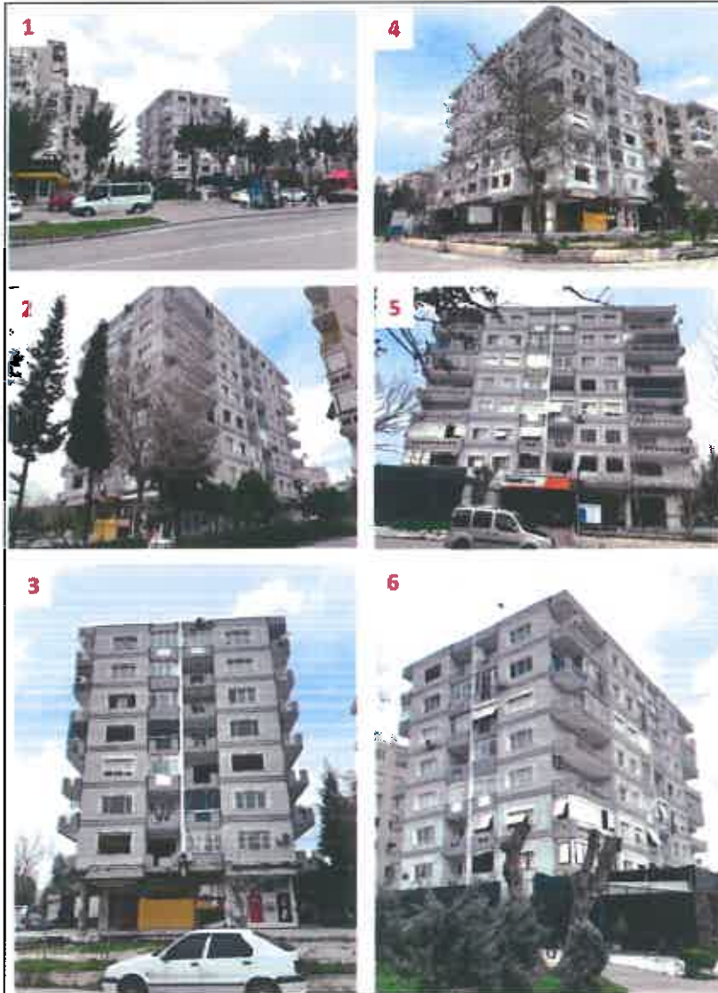
Şekil 9: Planlama Alanında Yer Alan Yapının Yıkım Öncesi Fotoğrafları
