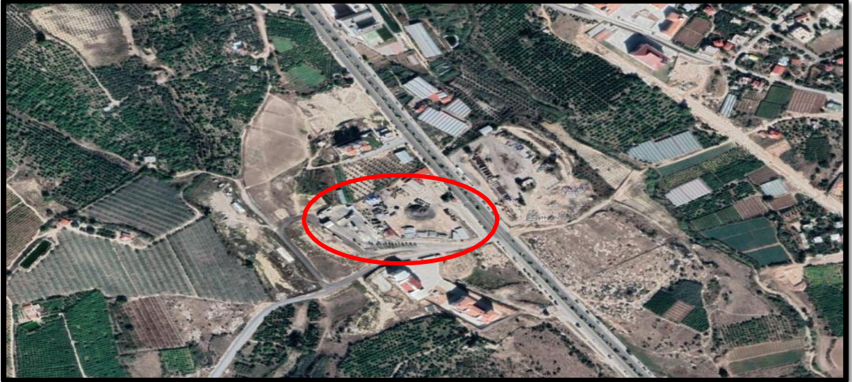
Harita 9 : Mersin İli Yenişehir İlçesi Katı Atık Aktarma İstasyonu (Mersin Büyükşehir Belediye Başkanlığı İklim Değişikliği ve Sıfır Atık Dairesi Başkanlığı)
