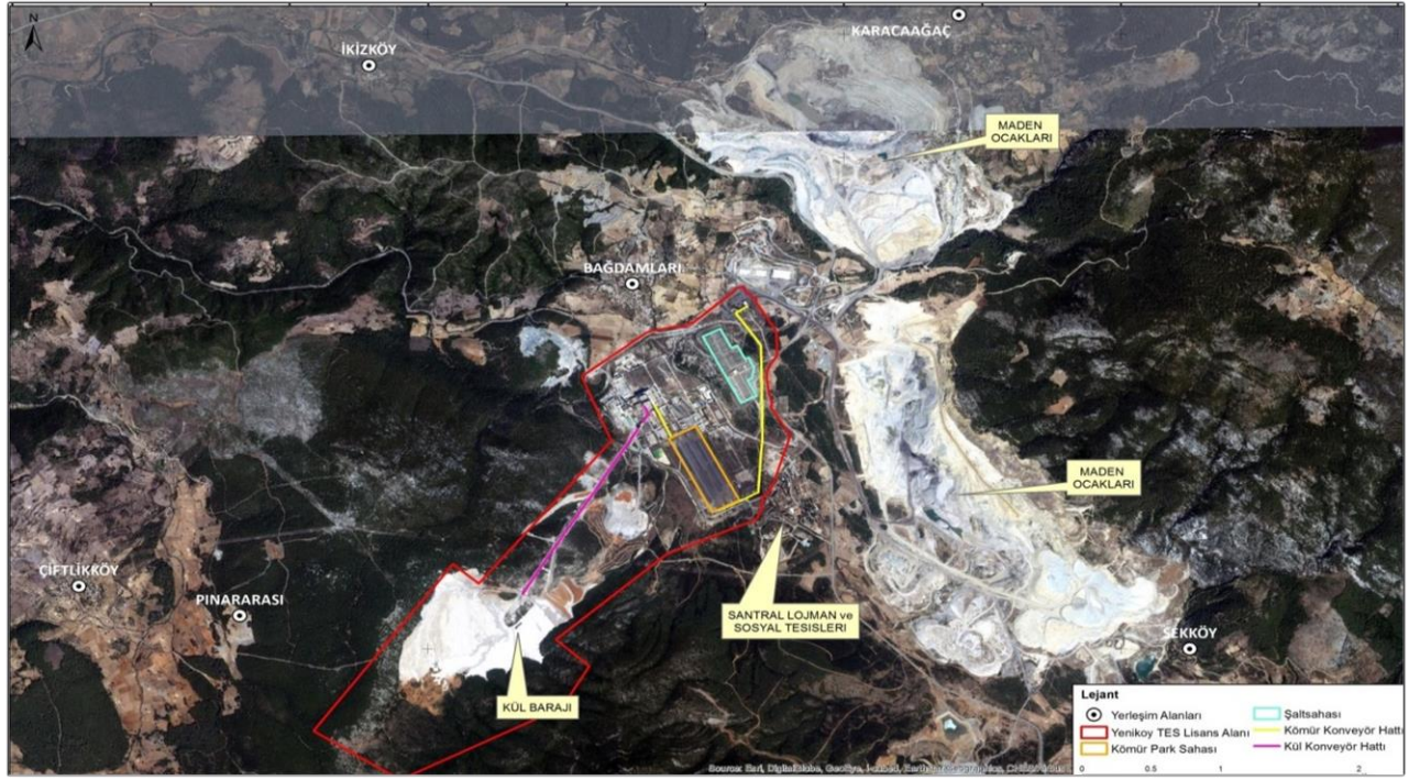
Harita 6-Yeniköy Termik Santrali, Kül Depolama Alanı Uydu Görüntüsü
