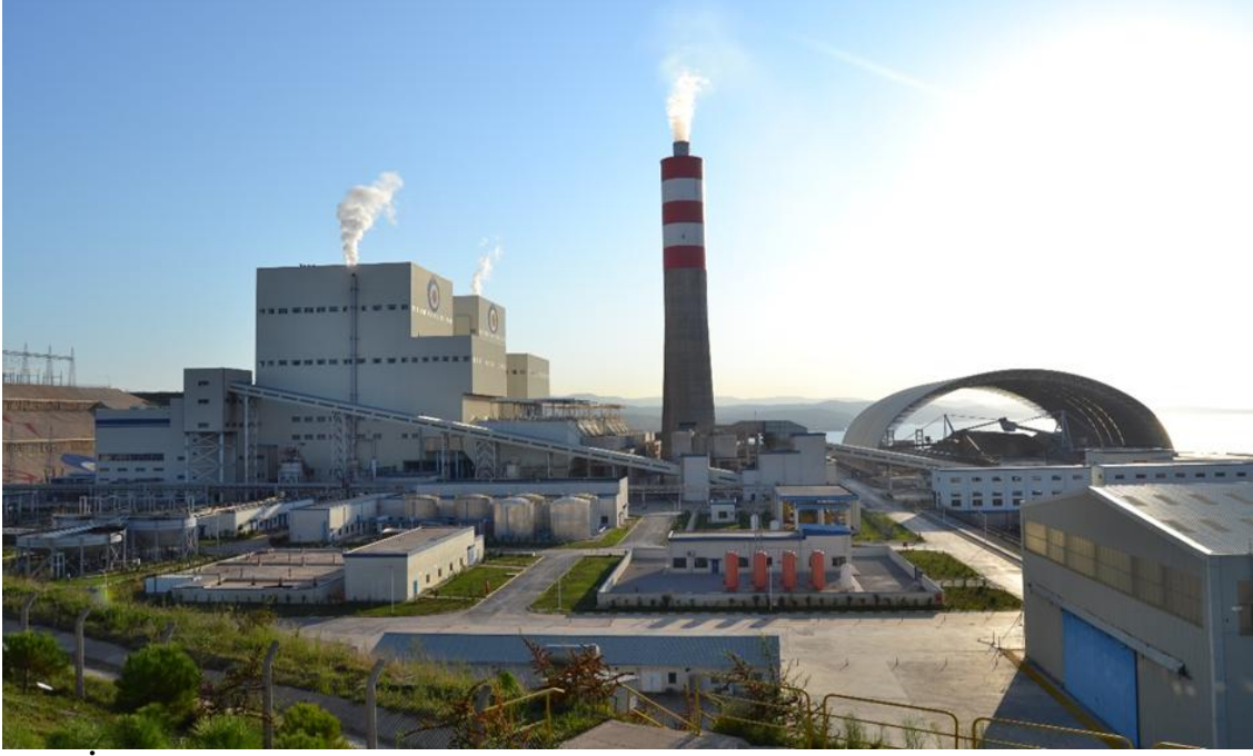
Resim 6- İÇDAŞ Bekirli Termik Santrali (İÇDAŞ Elektrik Üretim A.Ş.,2019)
