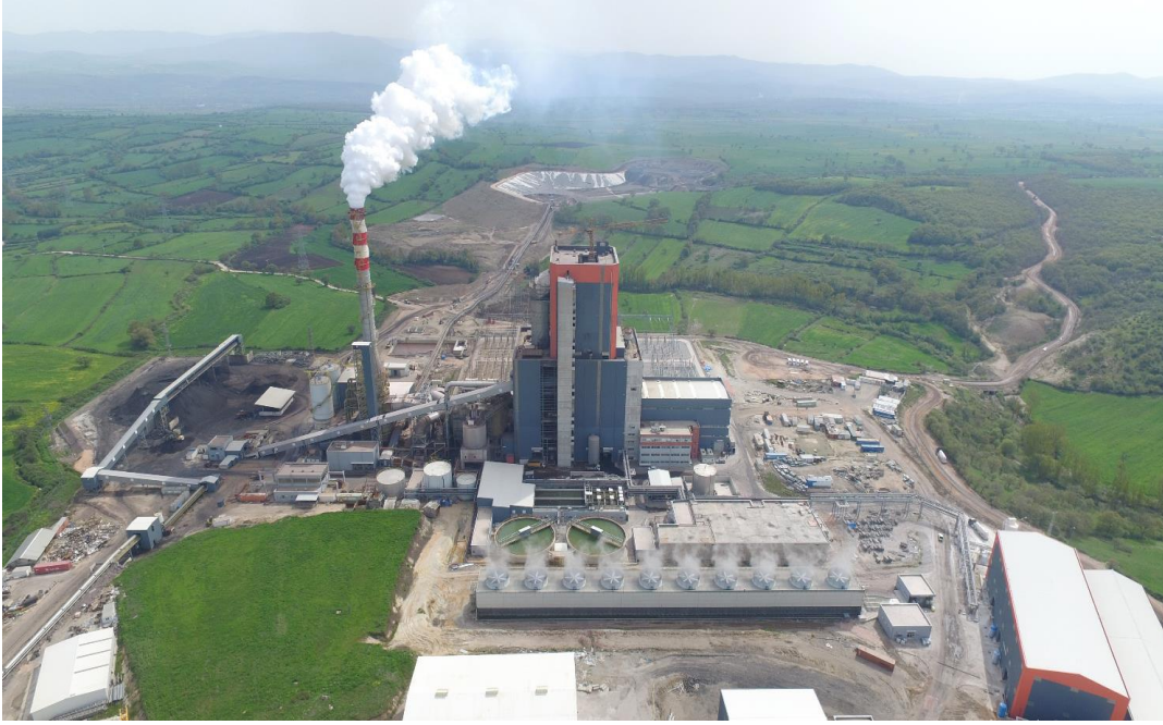
Resim 8-- Çan-2 Termik Santrali (ODAŞ, 2019)
