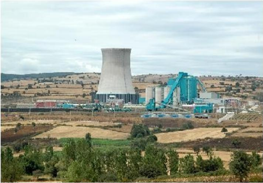
Resim 5 – 18 Mart Çan Termik Santrali (EÜAŞ,2019)
