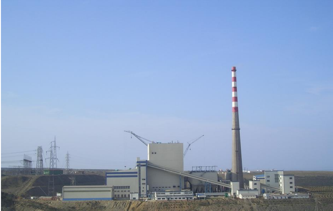
Resim 7— İÇDAŞ Değirmencik Termik Santrali (İÇDAŞ Demir Çelik Üretim A.Ş.,2019)
