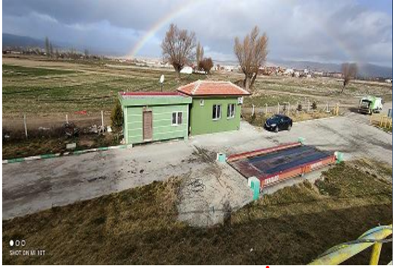
Şuhut Katı Atık Aktarma İstasyonu
