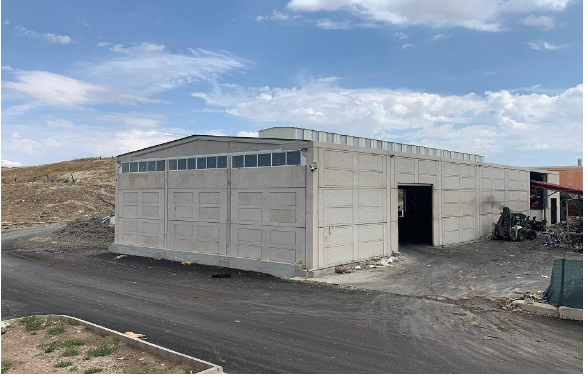
Atıktan Türetilmiş Yakıt Tesis
