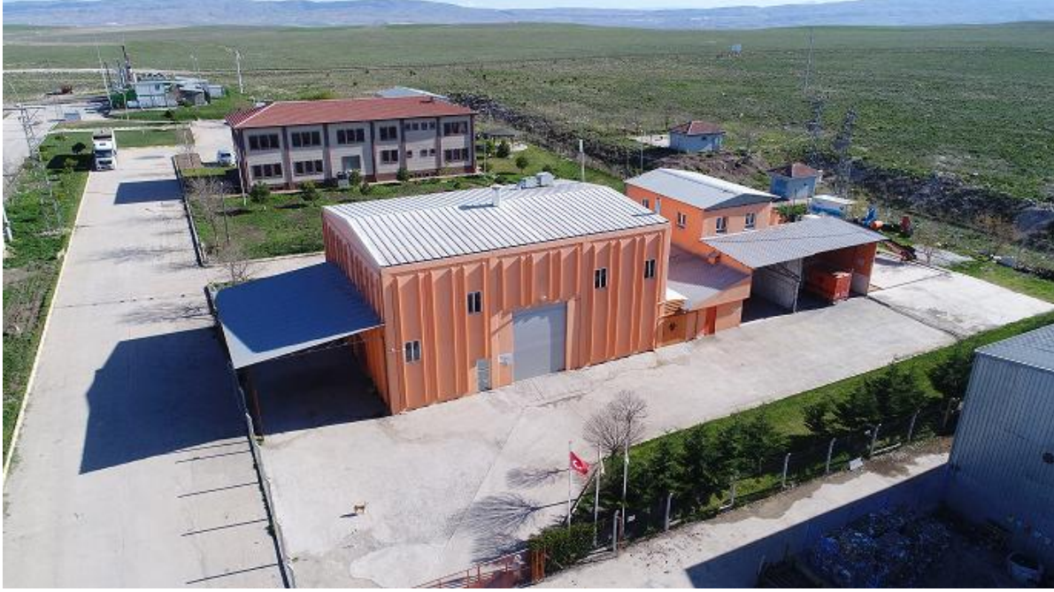
Tıbbi Atık Sterilizasyon Tesisi
