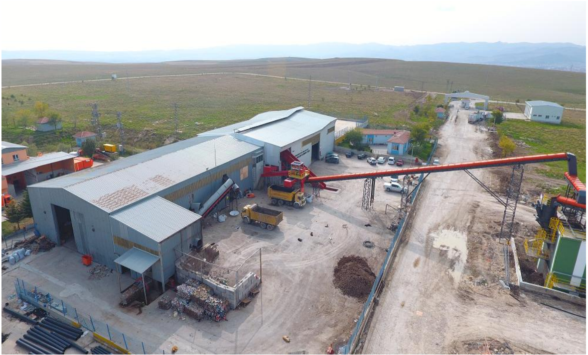
Katı Atık Ön İşlem Tesisi
