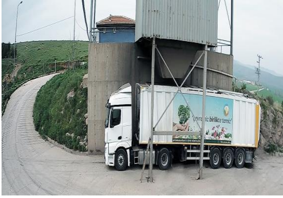
Sandıklı Katı Atık Aktarma İstasyonu
