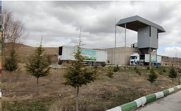
Bolvadin Katı Atık Aktarma İstasyonu
