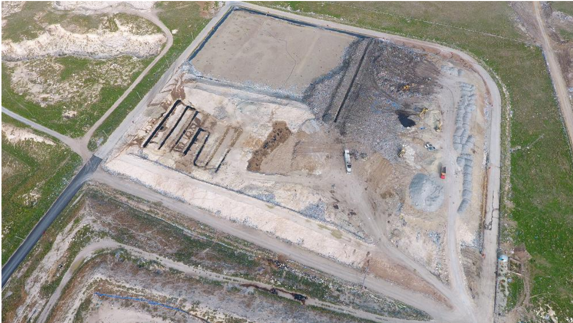
Atık Düzenli Depolama Lotu Son Hali
