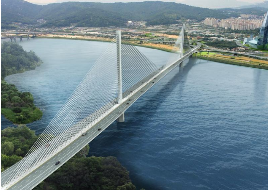
Şekil 4.11 Tasarım Aşamasında BIM Kullanılan Godeok Köprüsü [163]
