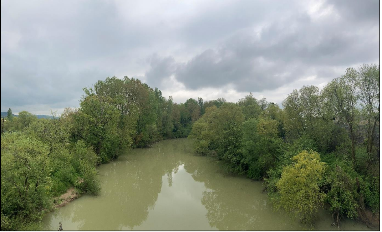
Resim 8. Bartın-3 Köprüsü Üzerinden Bartın Çayı Görünüşü
