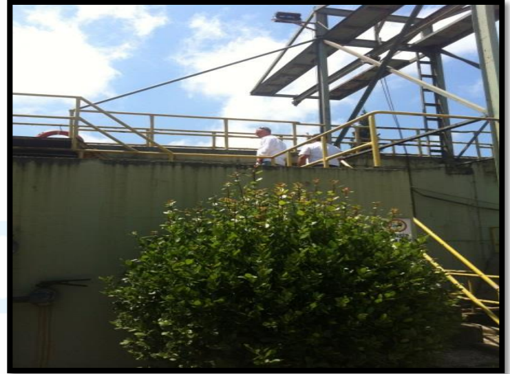
Dinarsu Atıksu Arıtma Tesisi
