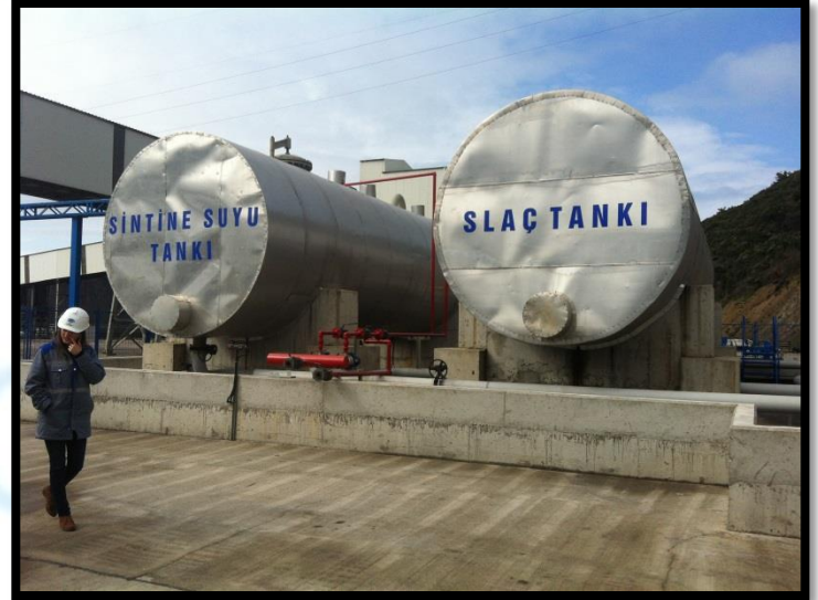
Eren Enerji Atık Kabul Tesisleri-3
