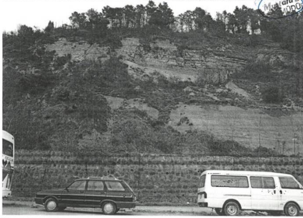
2- MEVCUT TAŞ DUVARIN KARŞIDAN GÖRÜNÜŞÜ
