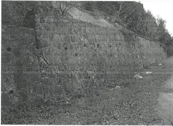
1- MEVCUT TAŞ DUVARIN ŞEHİR TARAFINDAN GÖRÜNÜŞÜ
