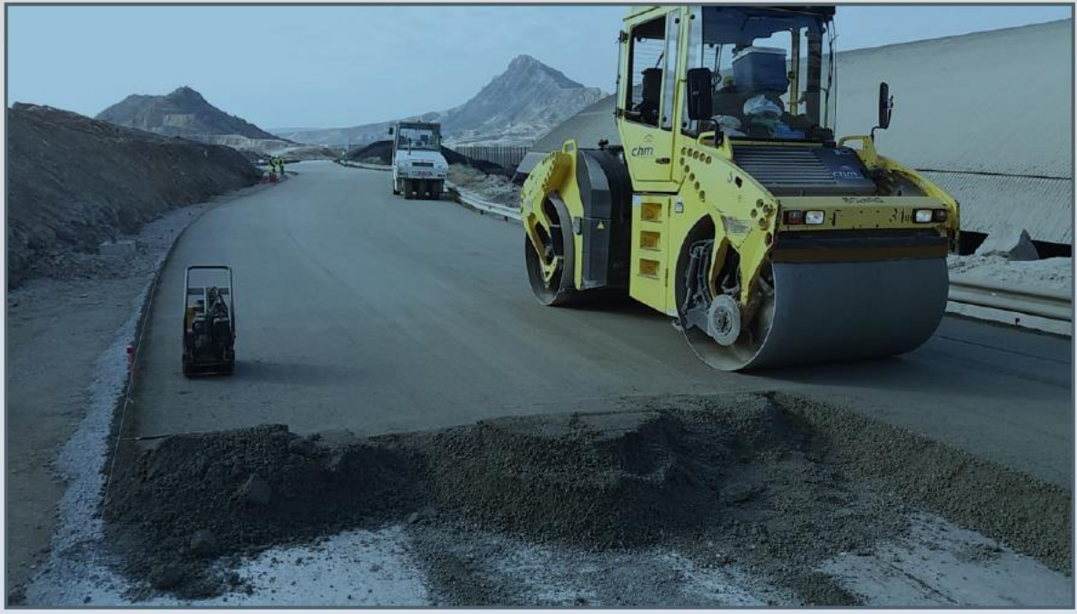
Şekil 6. SSB Betonun silindir ile sıkıştırılması (Tranter ve Merino, 2019)
