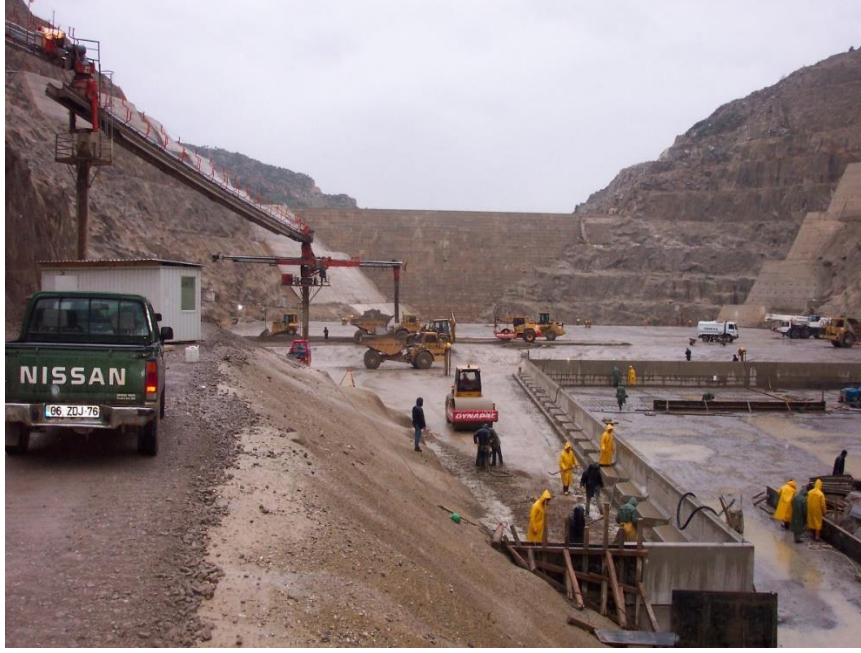
Şekil 3. Çine Barajında kullanılan prekast segmentleri tabandan döşenmeye başlanması.
