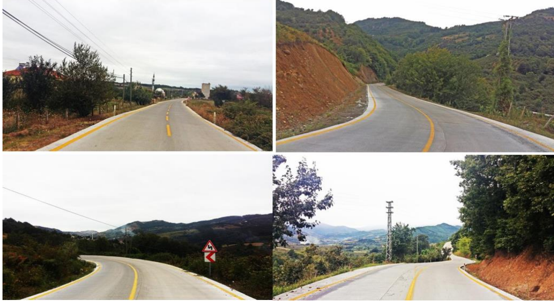
Şekil 12. Köydes ve Kırdes Projeleri kapsamında beton yol uygulamaları (Kaynak Türkiye Çimento Müstahsilleri Birliği: TÇMB)
