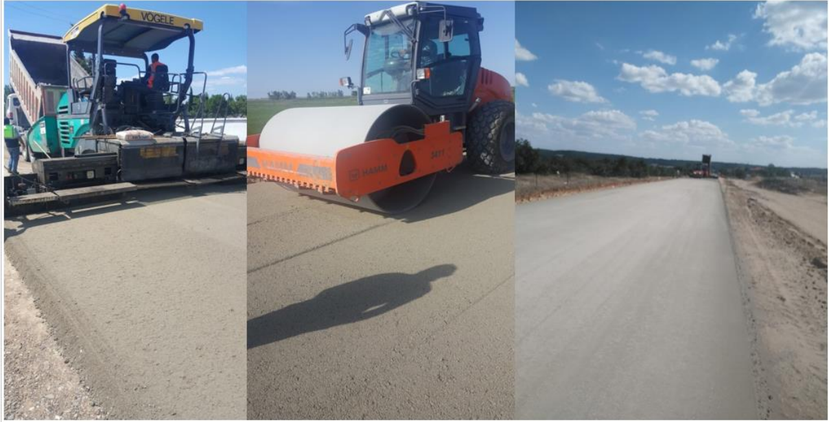
Şekil 9. Edirne İl Özel İdaresi tarafından 2018 yılında yapılan SSB Kaplama Uygulaması (Kaynak Türkiye Çimento Müstahsilleri Birliği: TÇMB)
