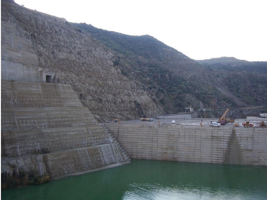
Şekil 4. Çine Barajında kullanılan prekast segmentlerin görünümü.
