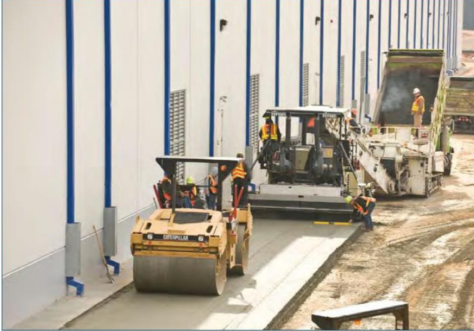
Şekil 2. Silindirle Sıkıştırılmış Betonun serimi ve sıkıştırılması (Harrington, 2010).
