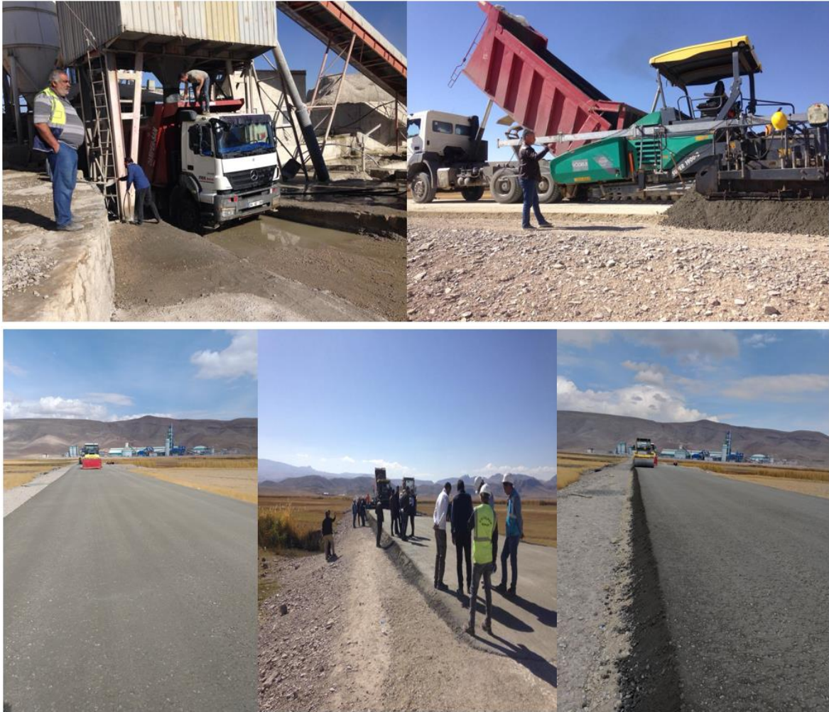
Şekil 11. Ağrı Valiliği tarafından 2018 yılında yapılan SSB Kaplama Uygulaması (Kaynak Türkiye Çimento Müstahsilleri Birliği: TÇMB)
