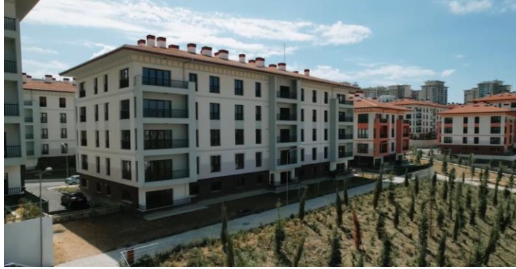
İstanbul Esenler Kentsel Dönüşüm Konutları
