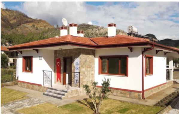
Muğla Marmaris Afet Konutları
