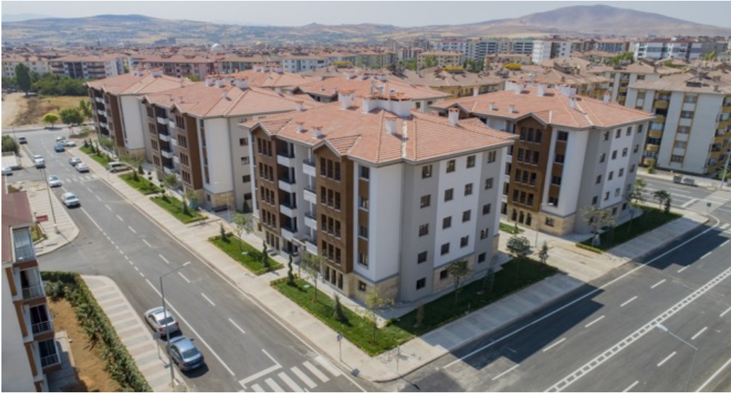
Elazığ Bizmişen Deprem Konutları
