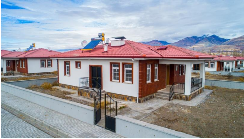
Erzincan Uluköy 130 konut
