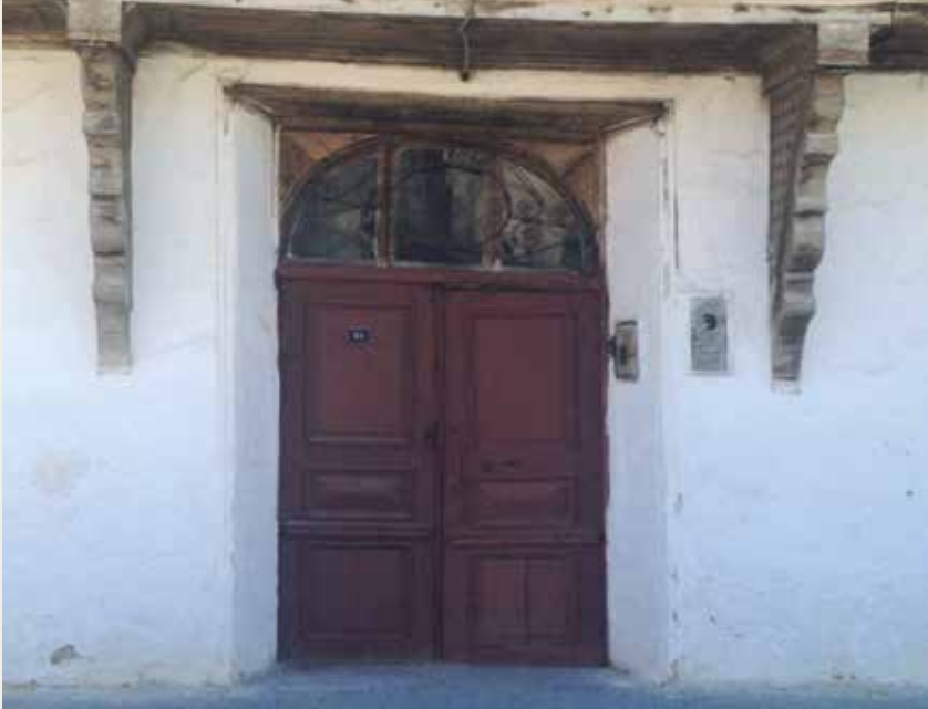
► Tablalı çift kanatlı ahşap giriş kapısı. [3]
