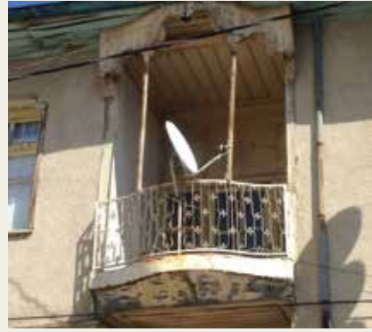
➤ Demir dikmeli ve korkuluklu bir balkon. [3]
