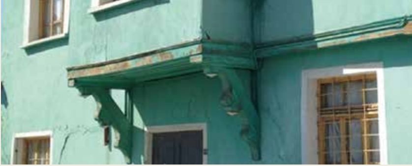
► Yan yüzü kapatılmamış ahşap payanda örneği. [3]
