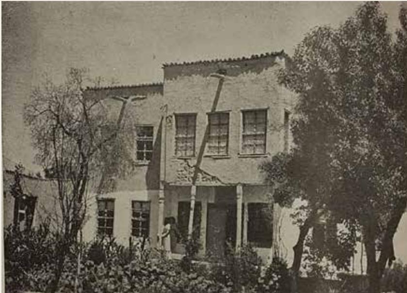
► Nakipoğulları Evinin Hayata bakan cephesi (Berk, 1951)
