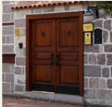
► Avlu giriş kapısında sade bir ahşap işçiliği. [5]
