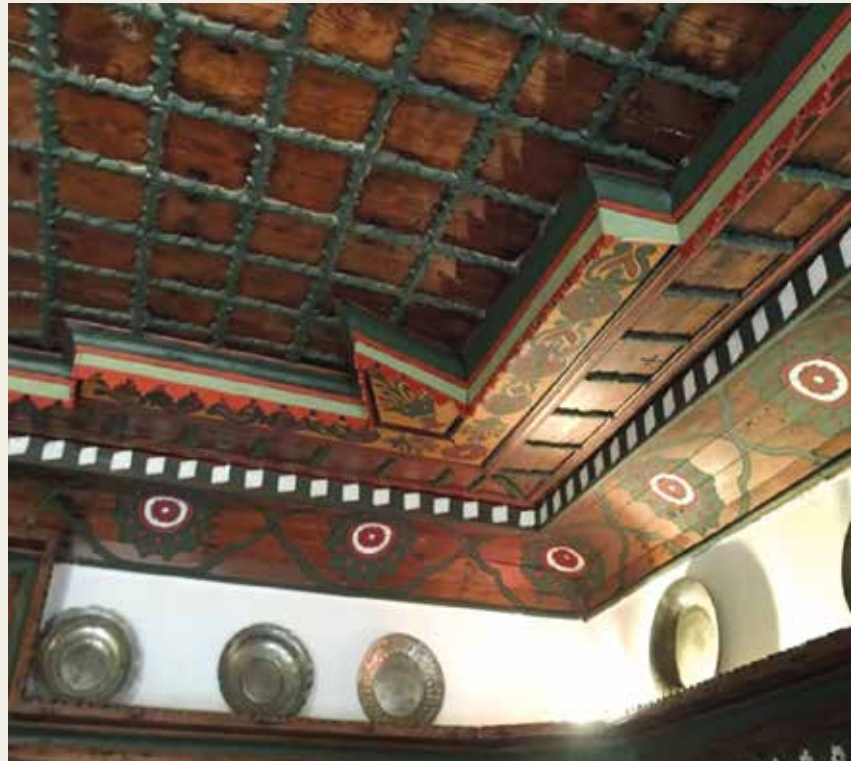
➤ Hürrem Dayı Evinin baş odasından ahşap çıtalı ve boyalı tavan kaplaması. [3]
