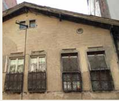
➤ Ahşap kanatlı pencere doğraması ve ahşap pencere kafesleri. [3]
