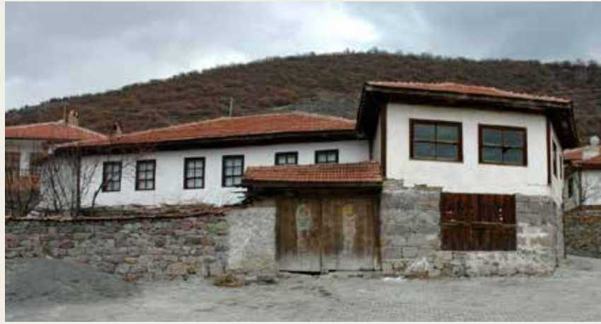
► Taş duvarlı bir avlu. Nihat Körhasan Evi, Ilgaz. [4]
