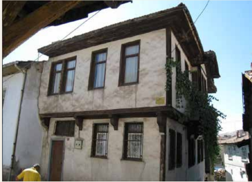
► Ahşap konsollarla desteklenmiş çıkma örneği. [4]
