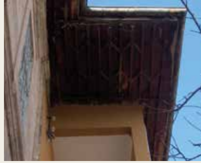
► Geleneksel Aksaray evlerinde ahşap saçak. (Karadayı Yenice, 2012)
