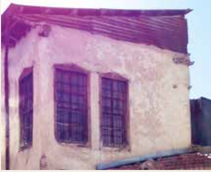
➤ Ahşap giyotin pencereler. [3]
