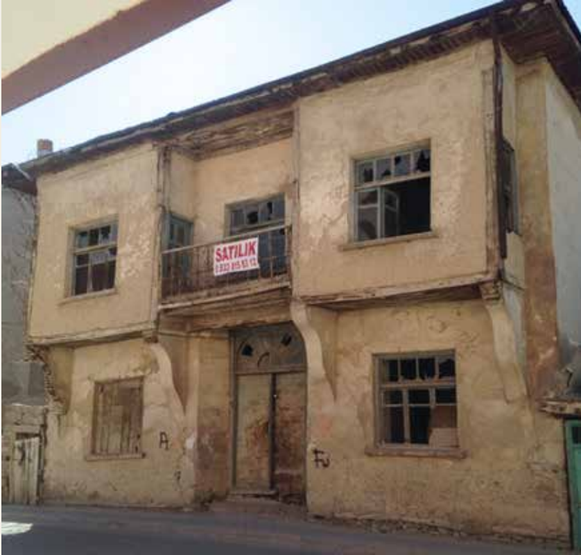
► İç sofalı, sofanın iki yanındaki odaları çıkma yapan bir ev. [3]
