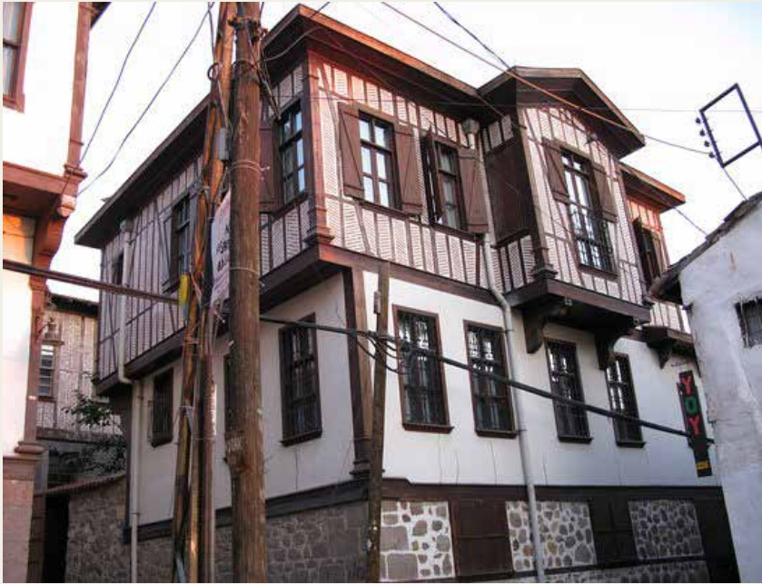
► Balık sırtı cephe. [9]
