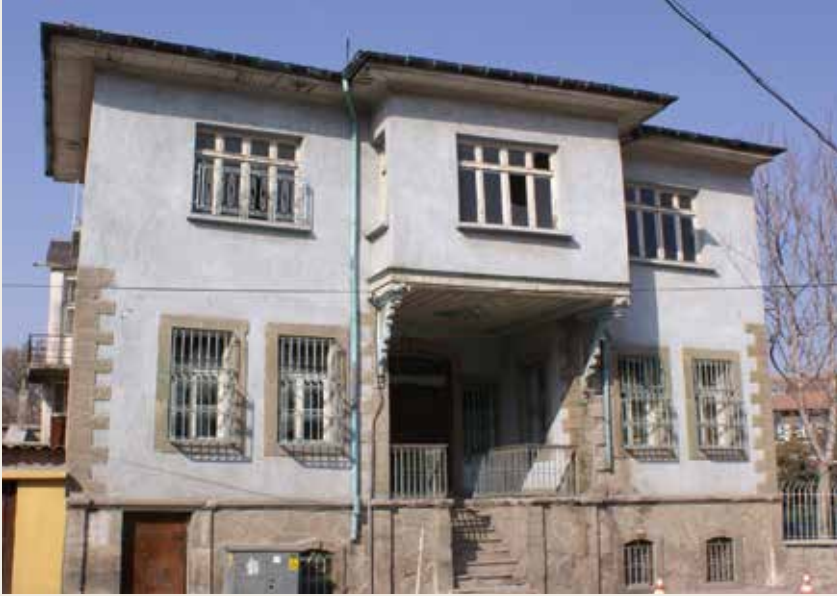
► Bodrumlu ve iki katlı, kesme taştan, yığma ve ahşap karkas yapım tekniği bir ev. [4]
