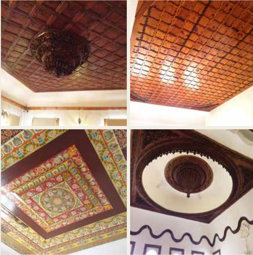
► Geleneksel Tokat evlerinden çıtakari ve kalemişi tavan süsleme örnekleri. [1]
