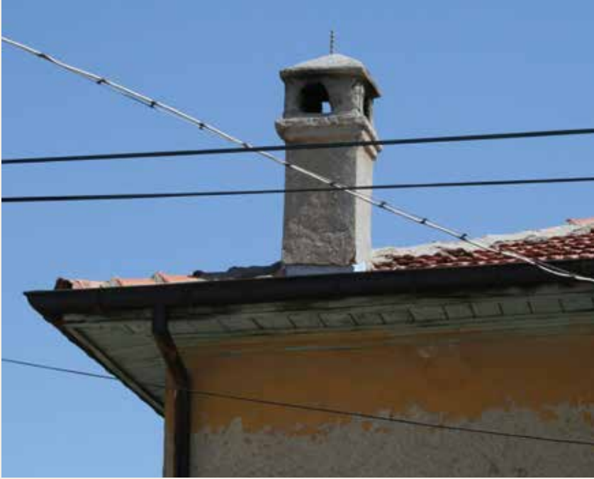
➤ Tuğla örgülü ve sıvalı baca örneği. [3]
