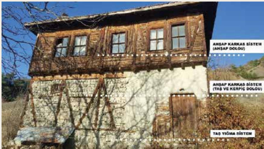
► Geleneksel ev yapı malzemeleri örneği. [8]
