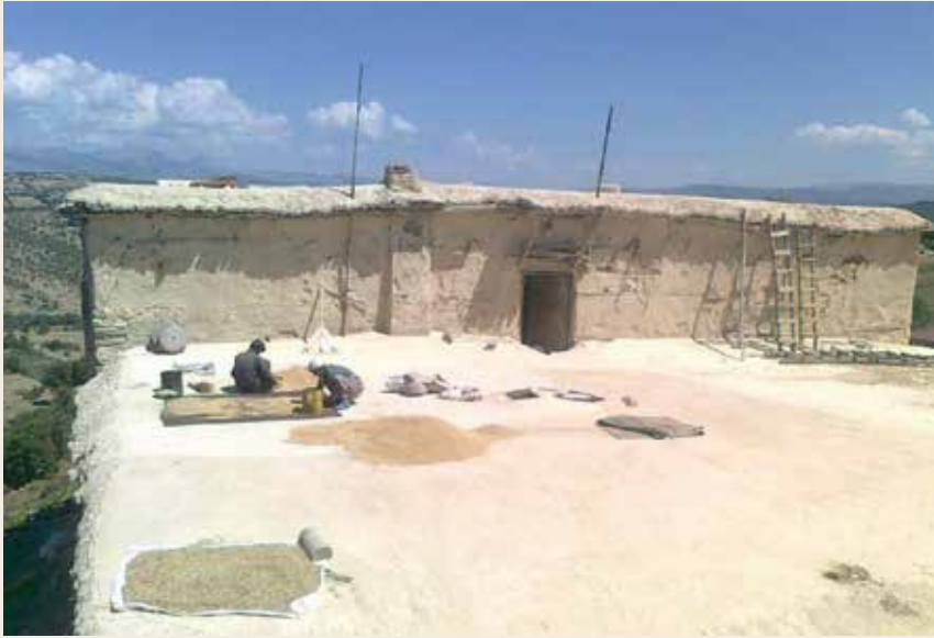
► Tunceli'de dam kullanımı örneği. [3]
