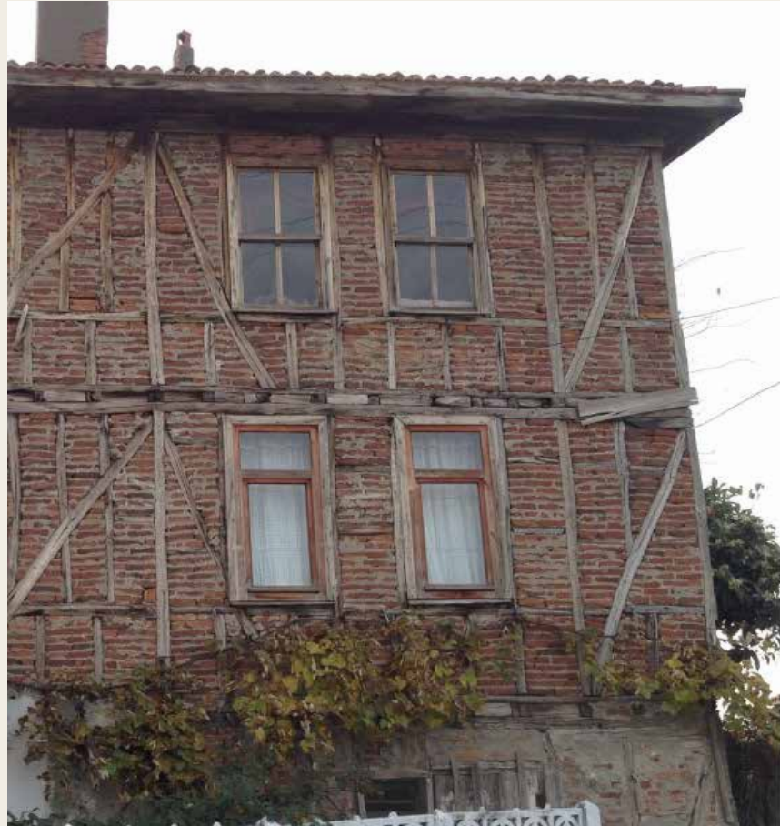
► Ahşap karkas sistemi örneği. [6]
