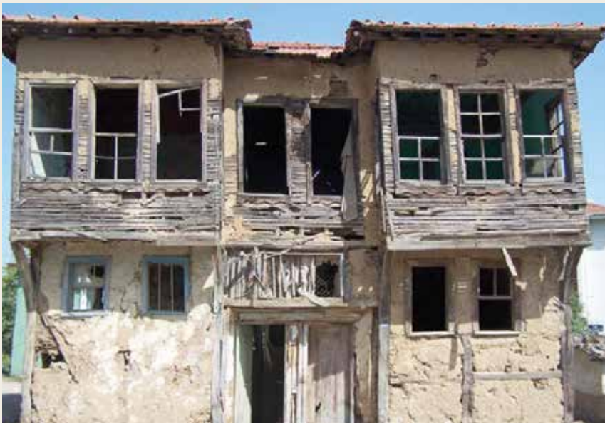
► Bağdadi kaplama üzeri sıva örneği. [5]
