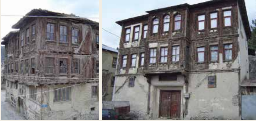
► Bolu ilindeki evlerde ahşap çatkı duvar arası ahşap dolgu örnekleri. [7]
