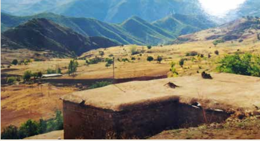
► Tunceli geleneksel konutlarında dam örneği. [2]
