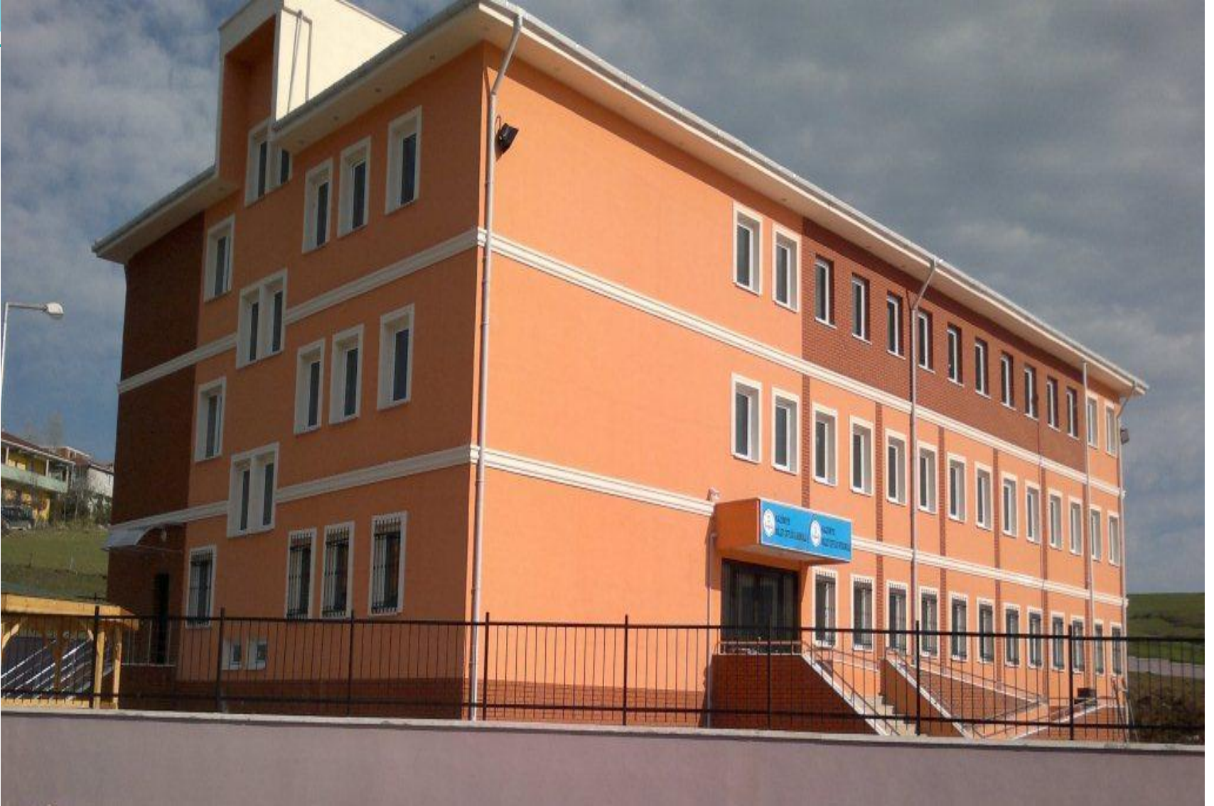
Kazımiye İlköğretim Okulu
