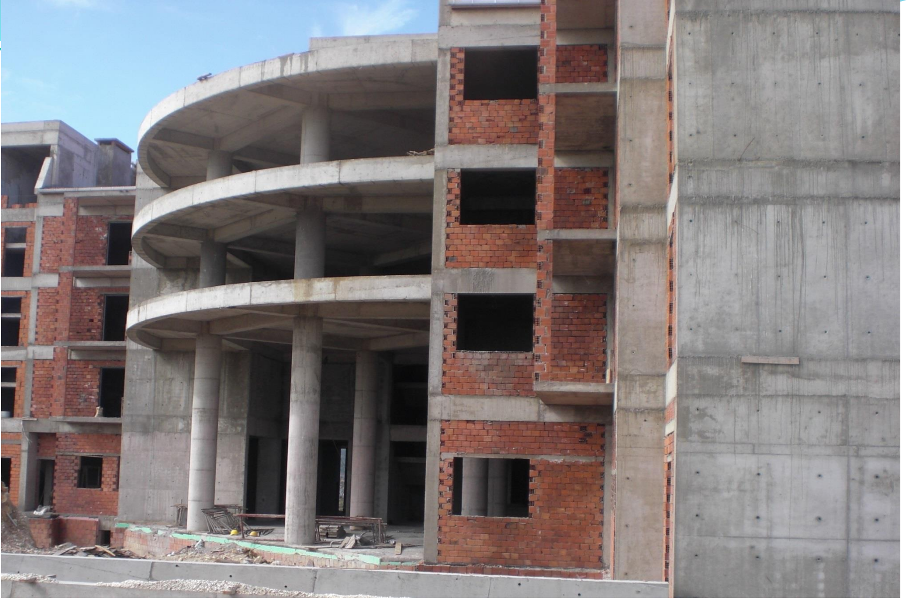
Çınarcık 100-120 kişilik huzurevi inşaatı
