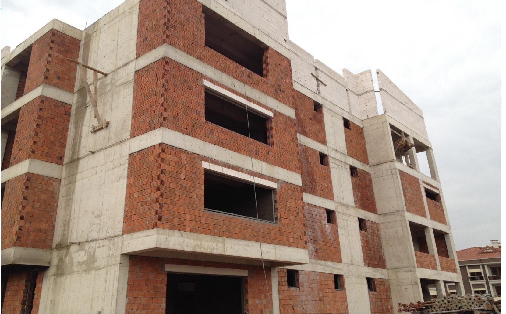
Hizmet Binası İnşaatı
