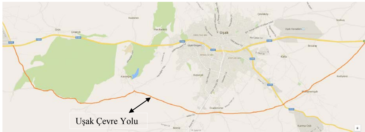
Şekil-4: Uşak il merkezi ve inşaat aşamasındaki çevreyolu güzergahı.
