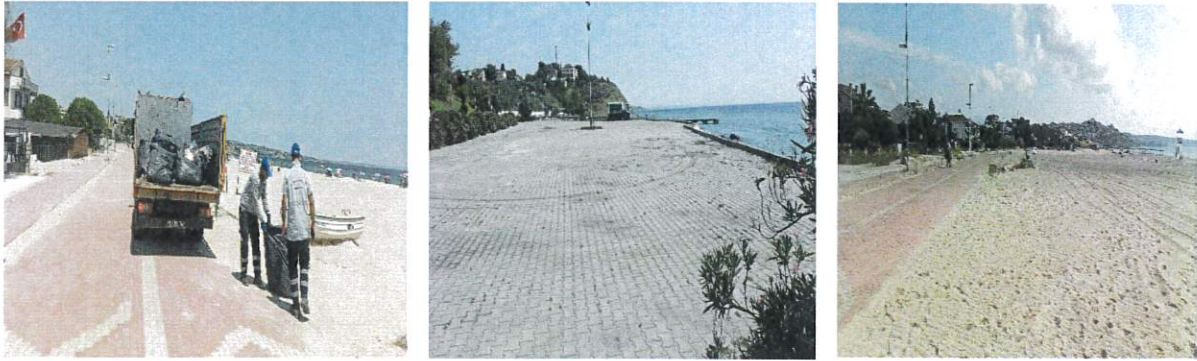
Şekil 17: Tekirdağ İli yürüyüş yollarında yapılan temizlik çalışmaları
