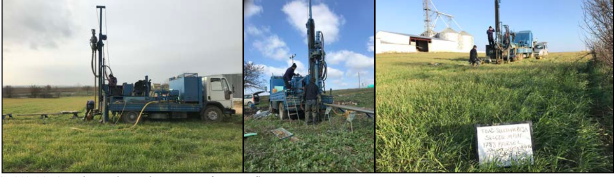
Şekil 10. Sondaj çalışmalarına ait fotoğraflar.
