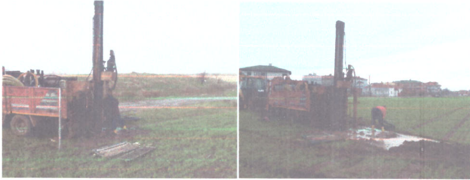
Şekil 6.2 Sondaj çalışmalarından SK-1 ve SK-4 ye ait örnek fotoğraflar
