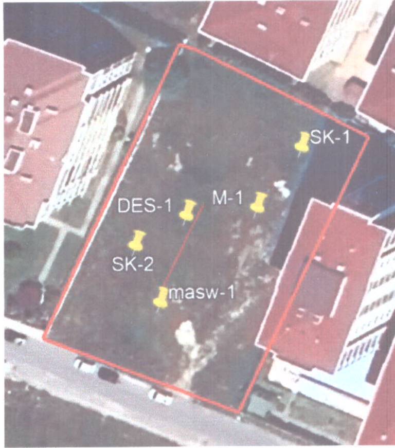
Şekil 6.1 İnceleme alanında açılan sondaj kuyuları
