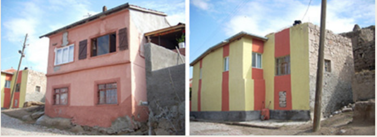
Fotoğraf 42: Selime beldesinde eski yapılardan onarım görmüş (yeni yapıya dönüştürülmüş) iki örnek
