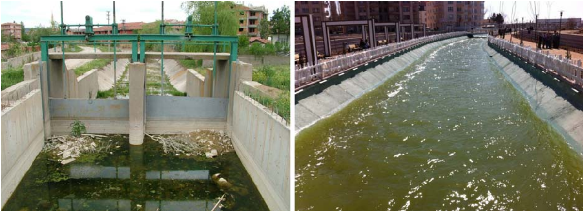
Şekil 12: Mogan Gölü sularını Gölbaşı Düzlüğüne, dolayısıyla Eymir Gölü'ne boşaltan kanal ve su kontrol yapısı
