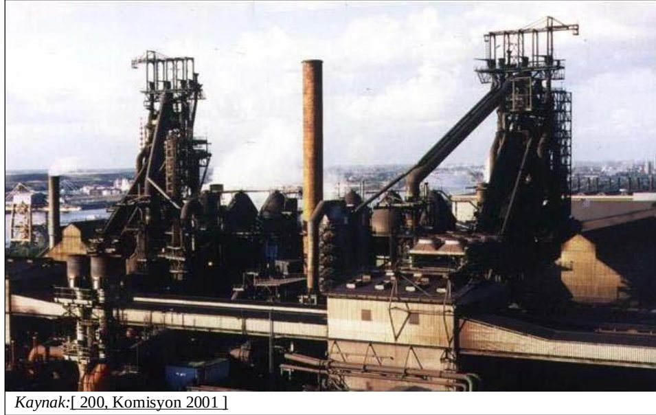
Şekil 6.1: Her birinde üç soba bulunan iki yüksek fırının ve sobaların atık gazının çıktığı bacanın genel görünümü
