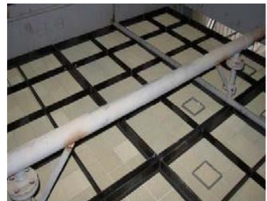
Şekil 1.68: SCR tekniğinde kullanılan modül konumu örneği
