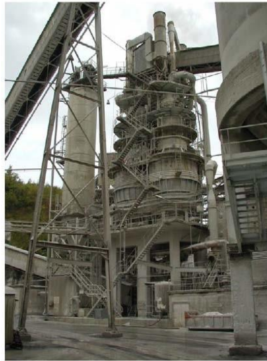
Şekil 2.23: PFRK örneği Kaynak: [44, EuLA, 2006]
