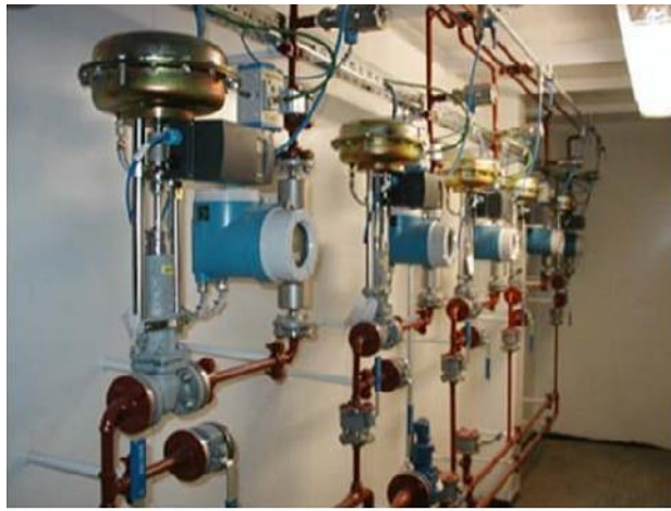
Şekil 6.28: Pnömatik vanalı ölçüm ve dozajlama istasyonu
