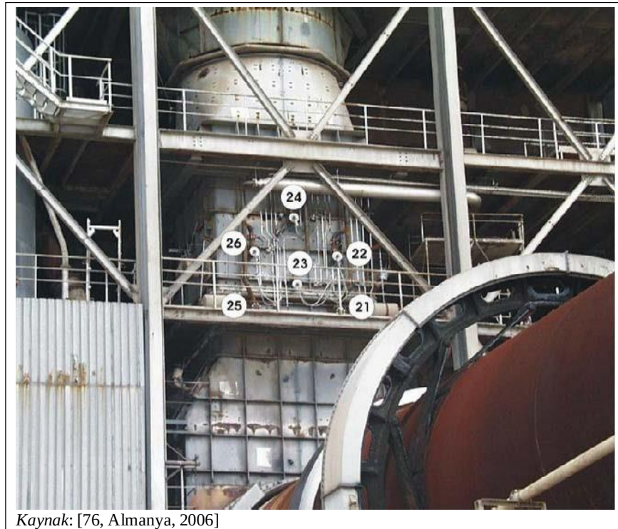
Şekil 6.8: Yüksek verimli SNCR ve 21 ila 26 numaralarıyla gösterilen boruyla amonyaklı su enjeksiyonu noktaları
