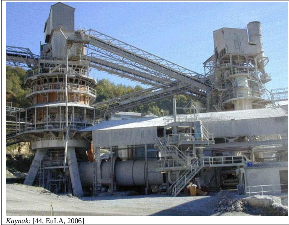
Şekil 2.34: Ön ısıtıcılı döner fırın örneği
