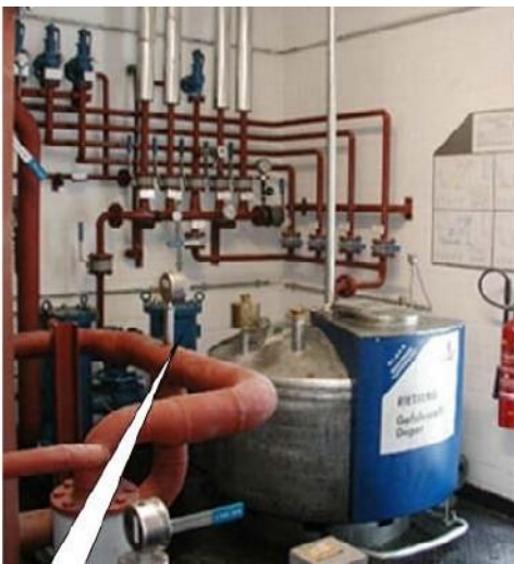
Şekil 6.27: 2 numaralı gösterilen filtre ve filtreyi temizlemek için atık konteynerine sahip pompa istasyonu
