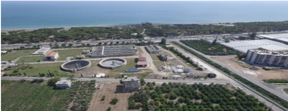
Şekil 9. Erdemli Su ve Atıksu Projesi-Atıksu Arıtma Tesis
