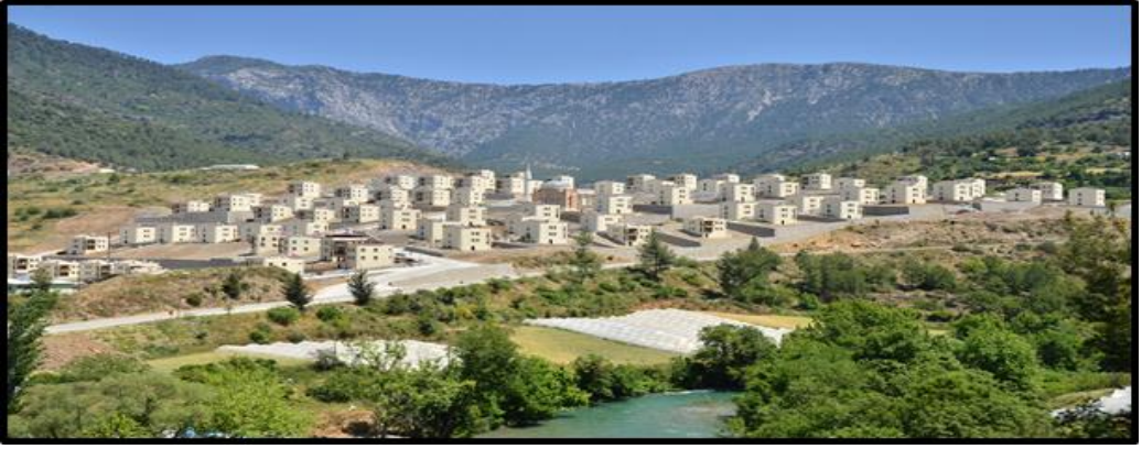
Şekil 8. Mersin- Alaköprü Barajı İskânı
