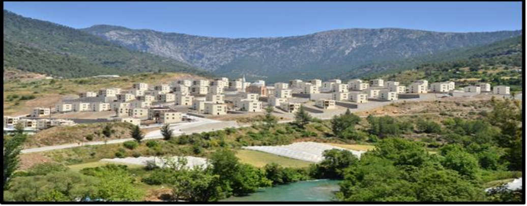
Şekil 8. Mersin- Alaköprü Barajı İskânı
