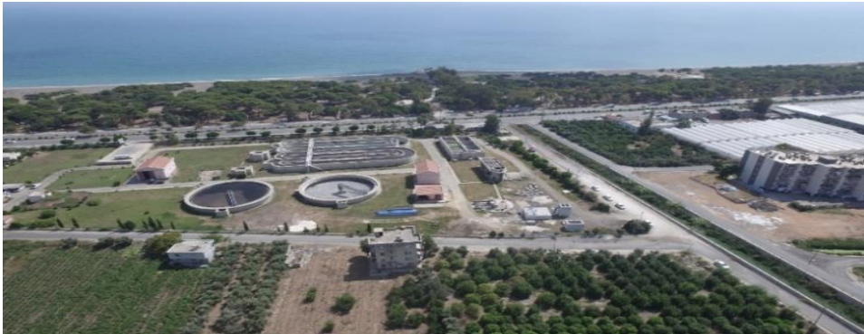
Şekil 9. Erdemli Su ve Atıksu Projesi-Atıksu Arıtma Tesis
