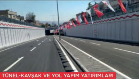
TÜNEL-KAVŞAK VE YOL YAPIM YATIRIMLARI
