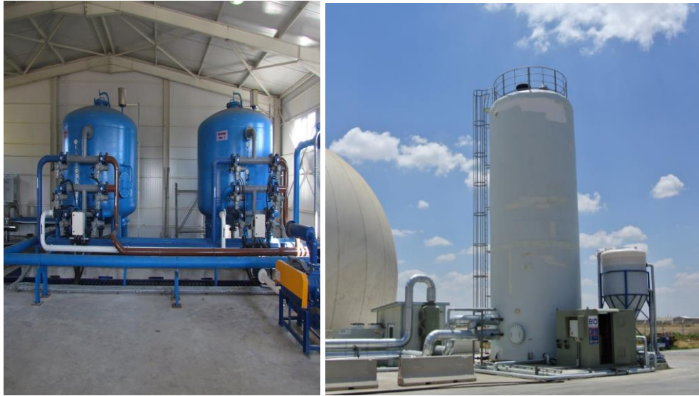
✓ Arıtılan Atıksu Geri Kazanım Ünitesi (sol) - Biyogaz Desülfürizasyon Ünitesi
