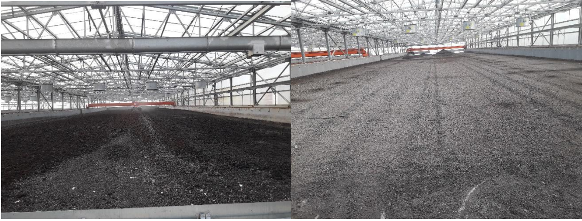
Çanakkale Atıksu Arıtma Tesisi solar kurutma ünitesi
