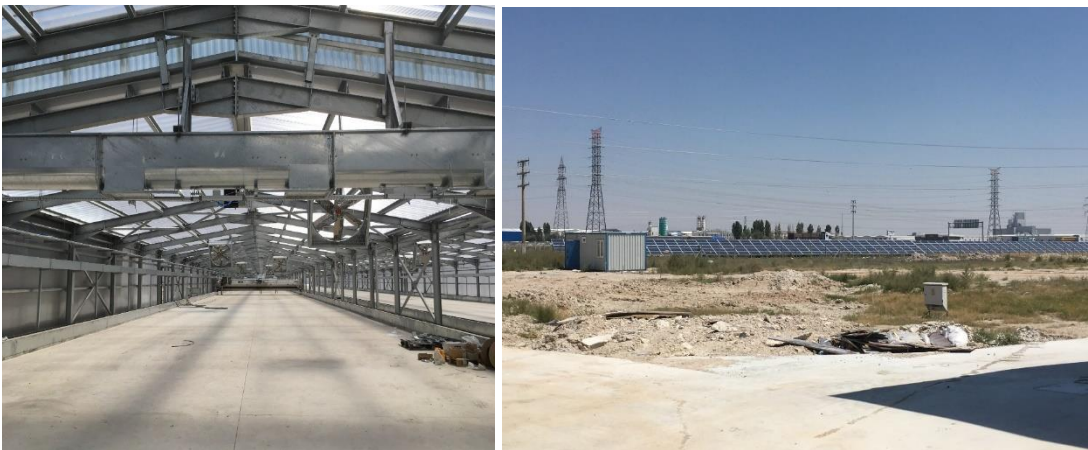
Konya OSB Solar Kurutma Ünitesi İç Görünümü (sol) – Güneş Panelleri (sağ)
