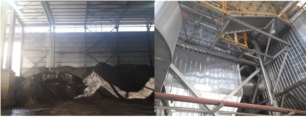
Çayırhan Sodyum Sülfat Tesisi kömür kabul ünitesi ve yakma ünitesi
