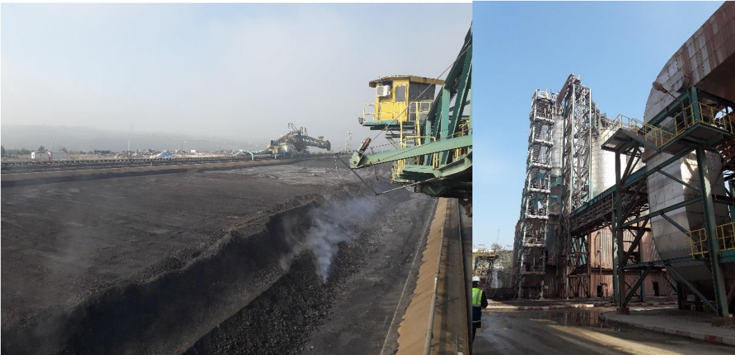
18 Mart Çan Termik Santrali kömür stok sahası
