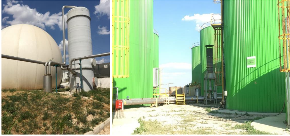
✓ Atakey AAT dahilindeki biyogaz depolama tankı ve desülfürizasyon ünitesi (sol) - Afyon Enerji Çürütücüler (sağ)
