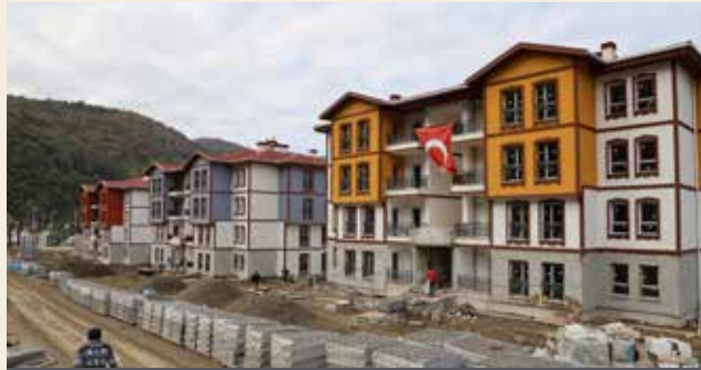
Sinop - Ayancık Afet Konutları Yapım Aşaması
