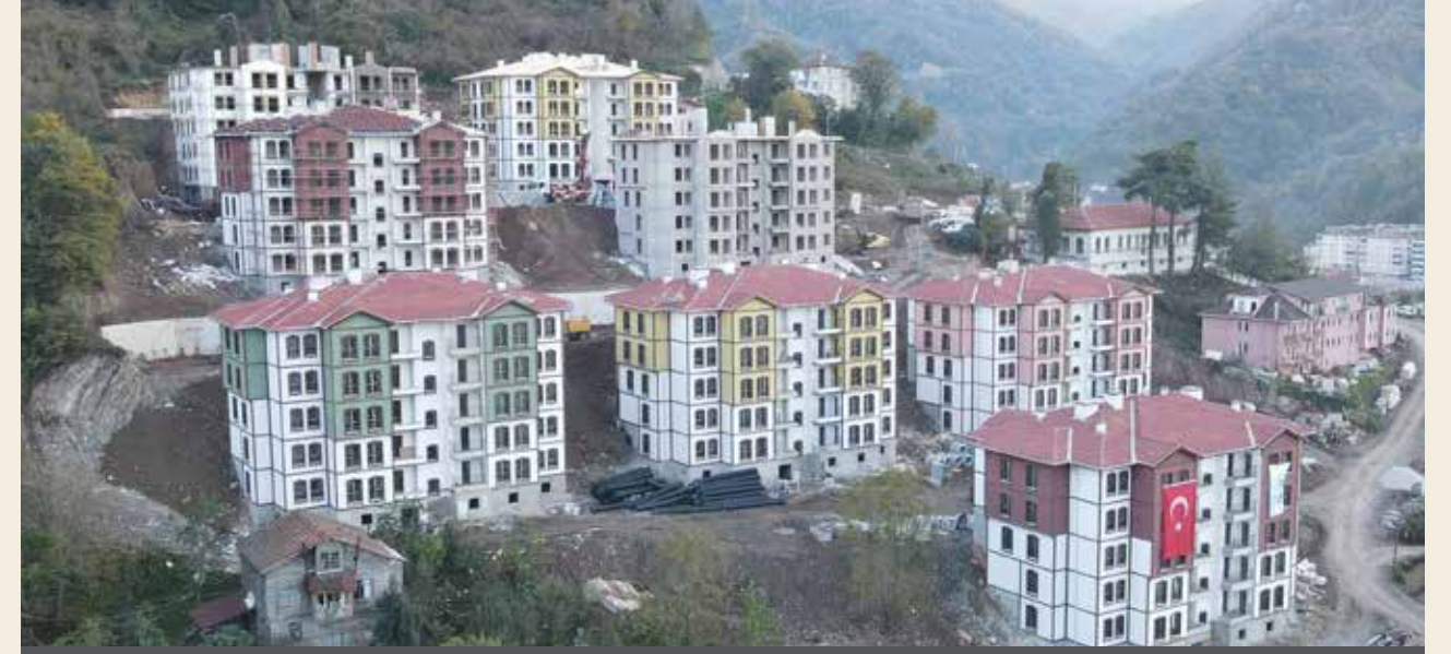
Kastamonu - Bozkurt Afet Konutları Yapım Aşaması
