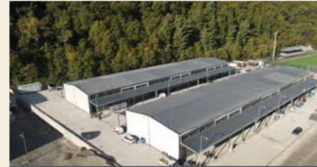
Kastamonu - Sanayi Sitesi Yapım Aşaması
