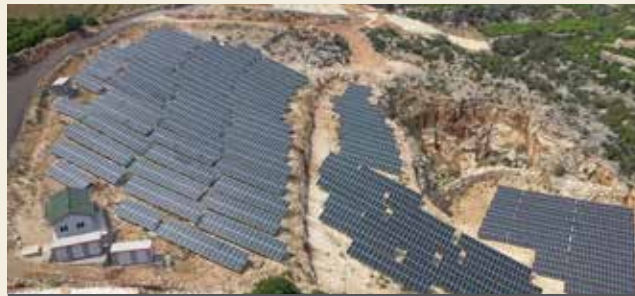
Mersin Güneş Enerjisi Santral
