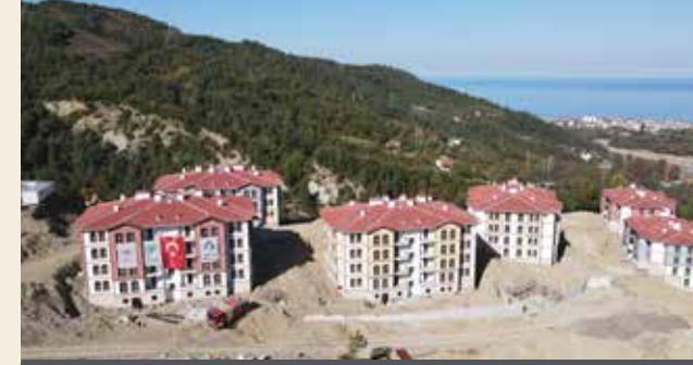
Kastamonu - Bozkurt Afet Konutları Yapım Aşaması
