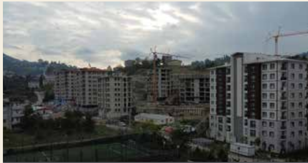
Rize - Yağlıtaş Afet Konutları Yapım Aşaması
