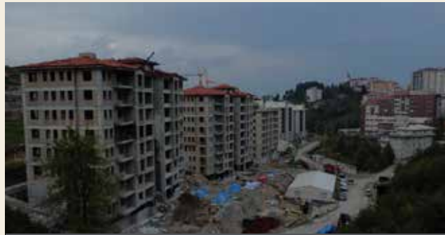
Rize - Yağlıtaş Afet Konutları Yapım Aşaması
