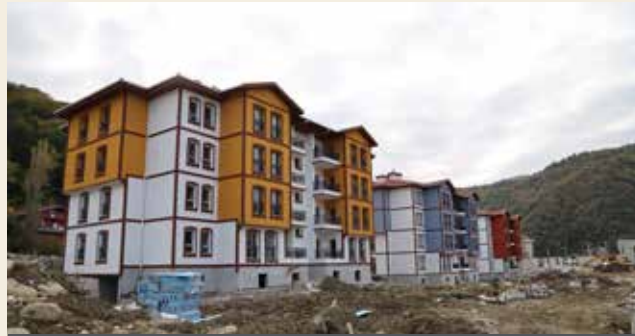
Sinop - Ayancık Afet Konutları Yapım Aşaması
