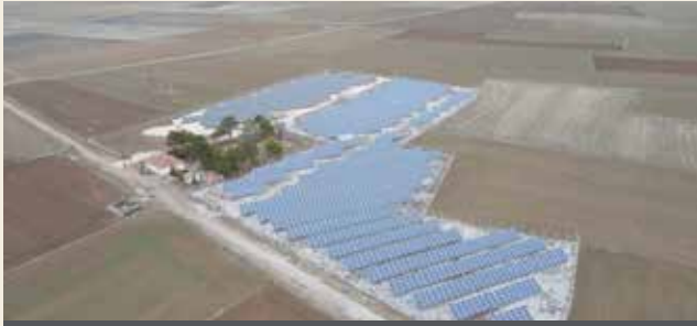
Nevşehir Güneş Enerjisi Santral
