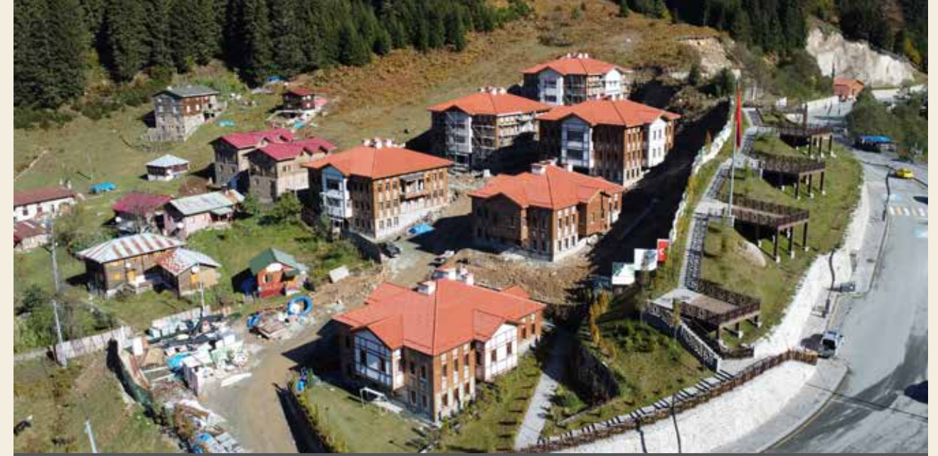
Ayder Yaylası Yeni Evler Yapım Aşaması
