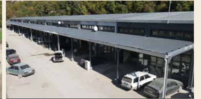
Kastamonu - Sanayi Sitesi Yapım Aşaması
