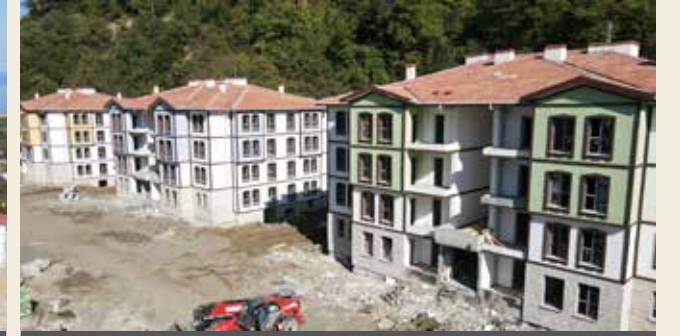
Kastamonu - Bozkurt Afet Konutları Yapım Aşaması
