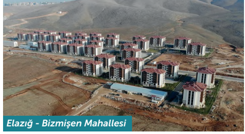
Elazığ - Bizmişen Mahallesi
