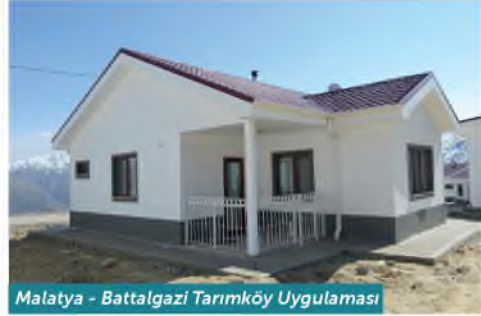
Malatya - Battalgazi Tarımköy Uygulaması
