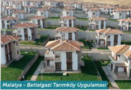
Malatya - Battalgazi Tarımköy Uygulaması
