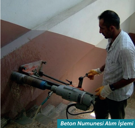
Beton Numunesi Alım İşlemi
