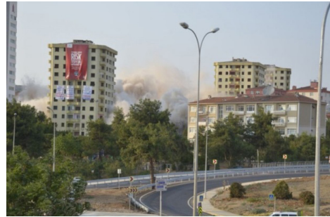
İstanbul Kartal Kontrollü Patlatmalı Bina Yıkımı
