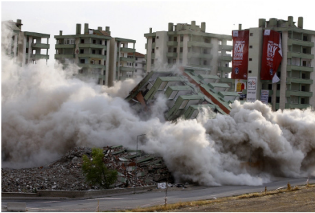
Ankara Sincan Kontrollü Patlatmalı Bina Yıkımı
