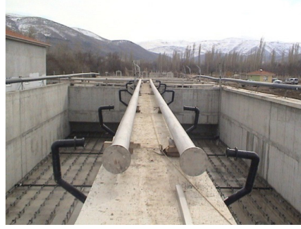
Atık Su Arıtma Tesis
