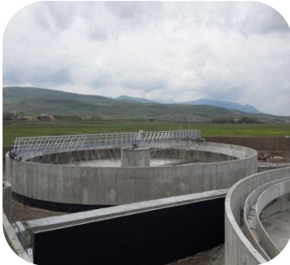
Şekil 30. Ceyhan Atıksu Arıtma Tesisi İnşaata
