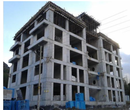
Şekil 26. Burdur Çevre ve Şehircilik İl Müdürlüğü
