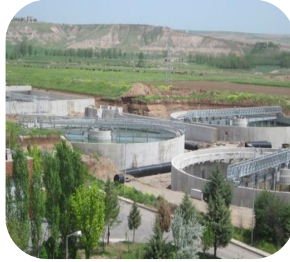
Şekil 31. Diyarbakır Atıksu Arıtma Tesisi İnşaata
