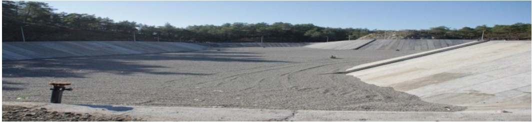
Şekil 28. Katı Atık Düzenli Depolama Tesisi İşi
