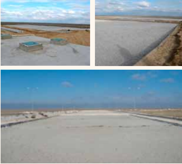
Şekil 49. Tuz Gölü ÖÇK Bölgesinde Doğal Arıtma Çalışmaları
