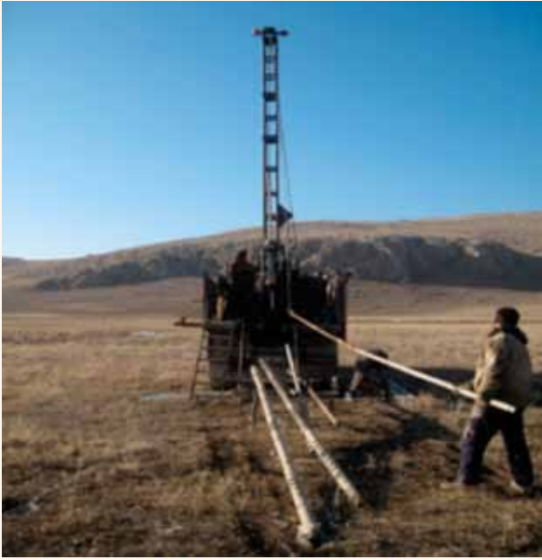
Şekil 20. Arazide Sondaj Çalışmalarından Bir Görünüm
