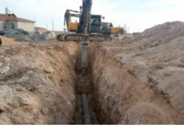
Şekil 51. Kanalizasyon Hattı Çalışmaları
