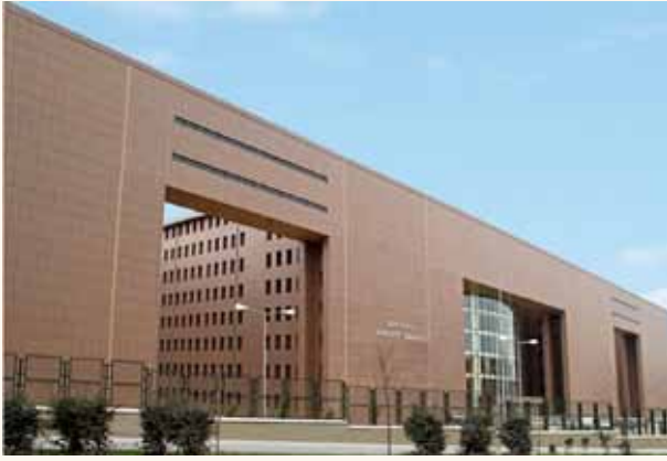
Şekil 36. İstanbul Bakırköy Adalet Sarayı
